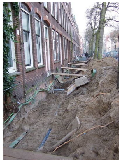
Figuur 6: Werk aan kabels en leidingen.
