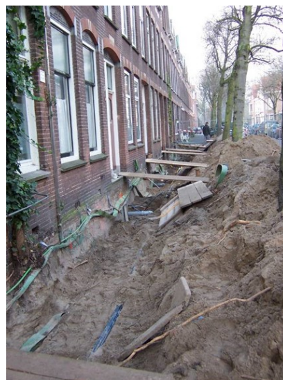
Figuur 6: Werk aan kabels en leidingen.
