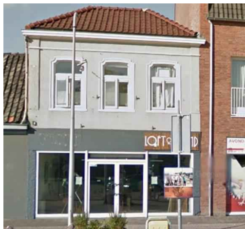
Figuur 69: De voorgevel van Hooftstraat 67 kort voor de sloop.
