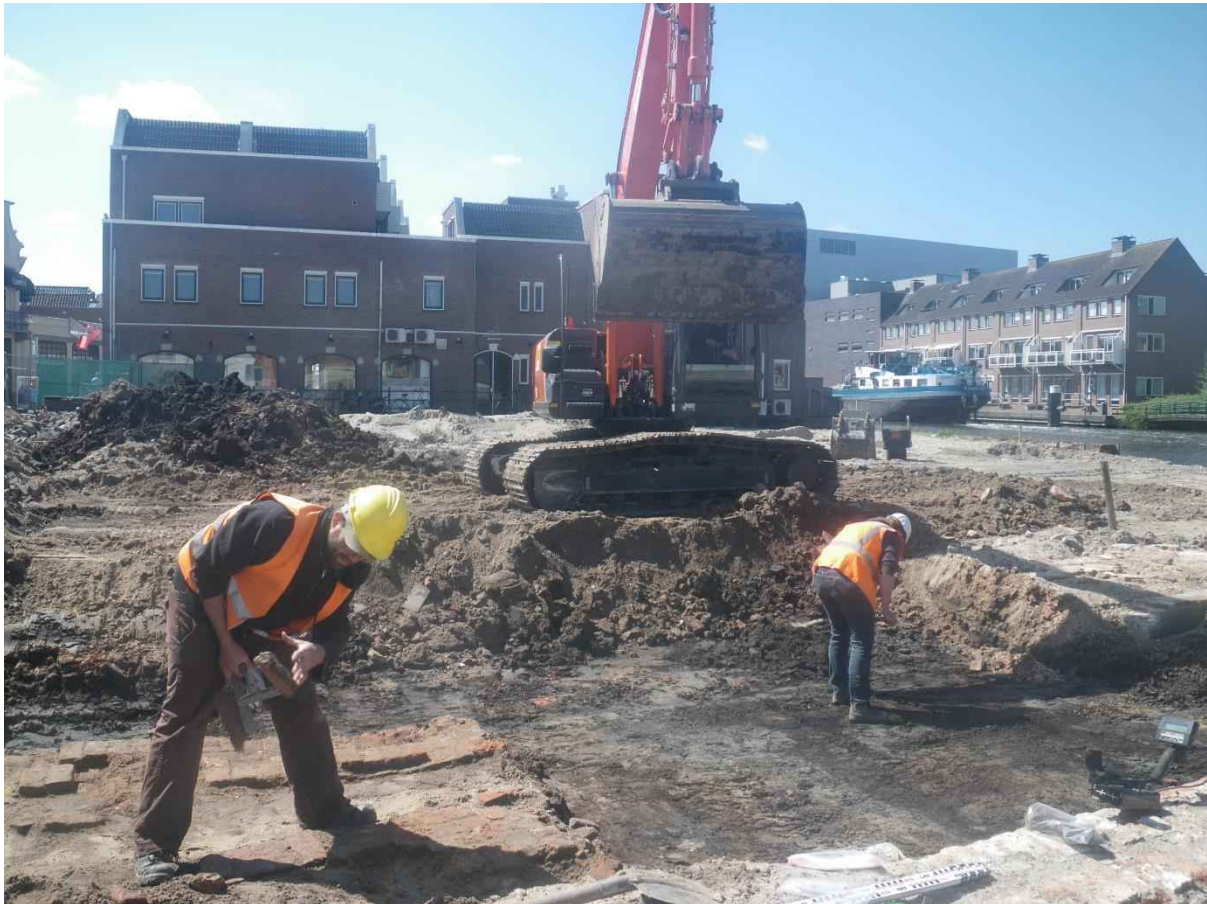
Figuur 4: Bij de aanleg van de vlakken werden vloeren en funderingen van baksteen aangetroffen.
