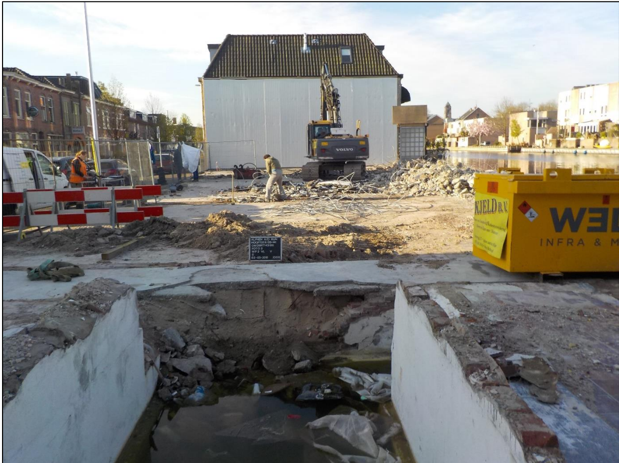
Figuur 1: Voorafgaand aan het onderzoek was de bebouwing gesloopt tot op het maaiveld. De opname is richting het zuiden genomen.
