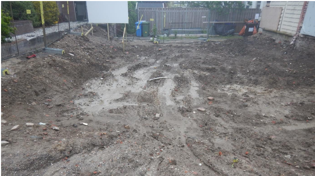
Figuur 5: Bij aankomst voor het hervatten van de werkzaamheden in juni 2016 bleek het perceel Hooftstraat 132-134 (WP1-2) al bouwrijp te zijn gemaakt. De opname is richting het oosten gemaakt.
