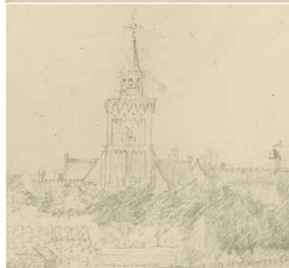
afbeelding 179. Gezicht westgevel van de Dorpskerk van Bodegraven , over de Rijn heen gezien, 1777. Bron: ELO, obj.nr.: PV_PV72653A.
