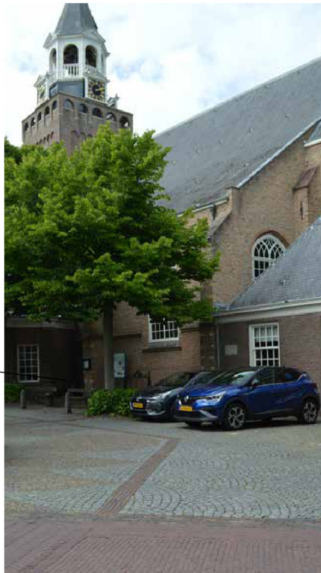
afbeelding 20. Het oostelijk deel van de zuidgevel van het schip, met rechts de in 1829 aangebouwde consistorie.
