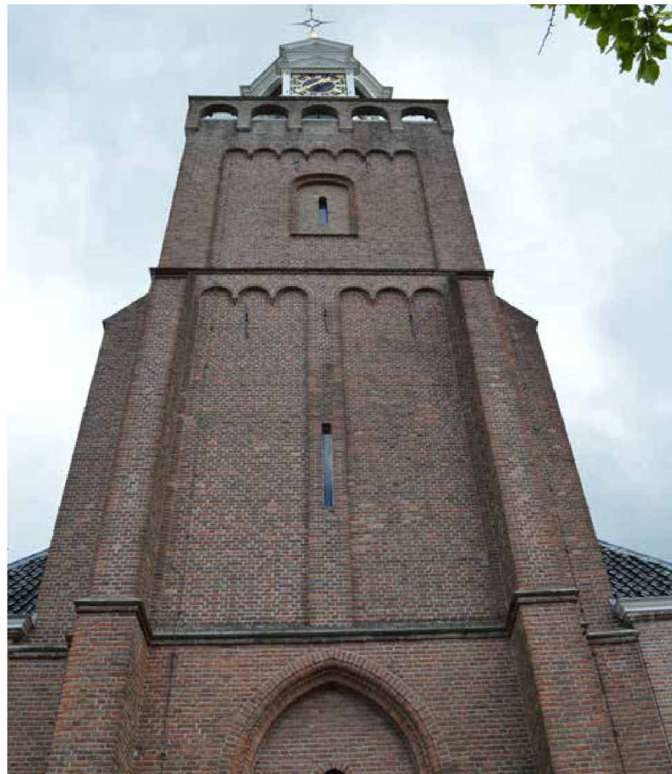
afbeelding 11. De westelijke entree ter plaatse van de toren: tweede en derde geleding. Het metselwerk van de toren is in 1972-73 geheel uniform gemaakt.
