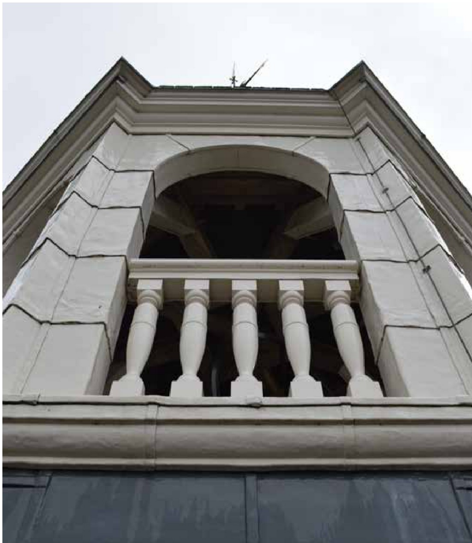
afbeelding 39. De voet van de torenspits (1972-73), waarin de luiklok is geplaatst. De voet werd achtkantig uitgewerkt met hierin getoogde openingen met gebalusterde balustrades. Het geheel werd bekleed met lood, waarbij het uiterlijk van natuursteenblokken werd gecreëerd.
