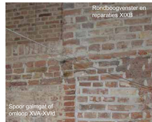
afbeelding 64. De zuidgevel uit voorgaande afbeelding op ooghoogte vanaf de tweede verdieping.
