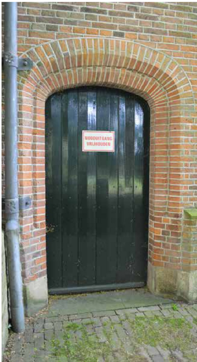
afbeelding 35. Deur aan de oostzijde van de middentravee, gerealiseerd in 1968-71.
