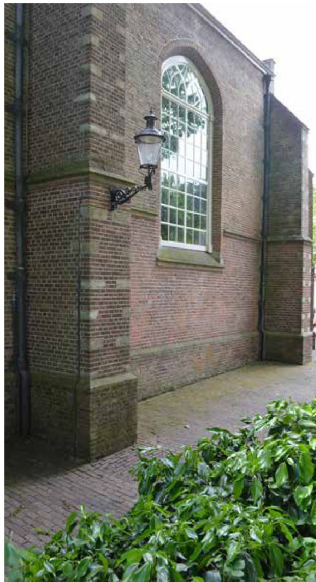
afbeelding 36. De westelijke travee van de noordgevel van het schip.
