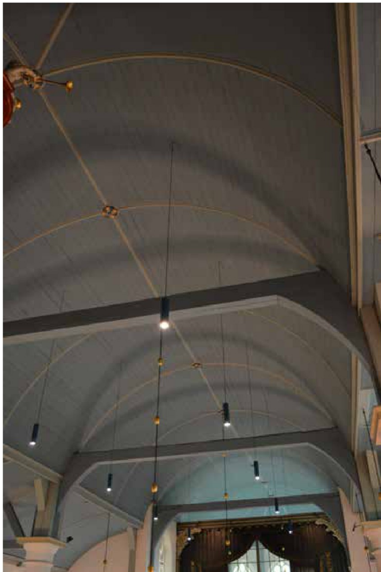
afbeelding 69. Houten tongewelf (ca 1771) van het schip en de onderste dekbalkjukken van de gebinten (1674).
