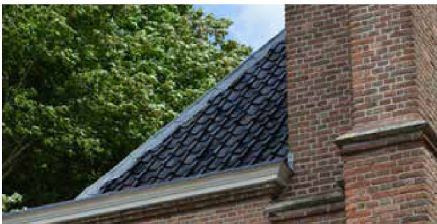
afbeelding 7. Noordelijke zijbouw van de kerktoeren; geheel opnieuw opgetrokken gedurende de restauratie van 1972-73. De houten vensters met traceringen en de zijdeur werden toen voorzien. Het dak is gedekt met rechtsdekkende blauwe geglazuurde pannen.
