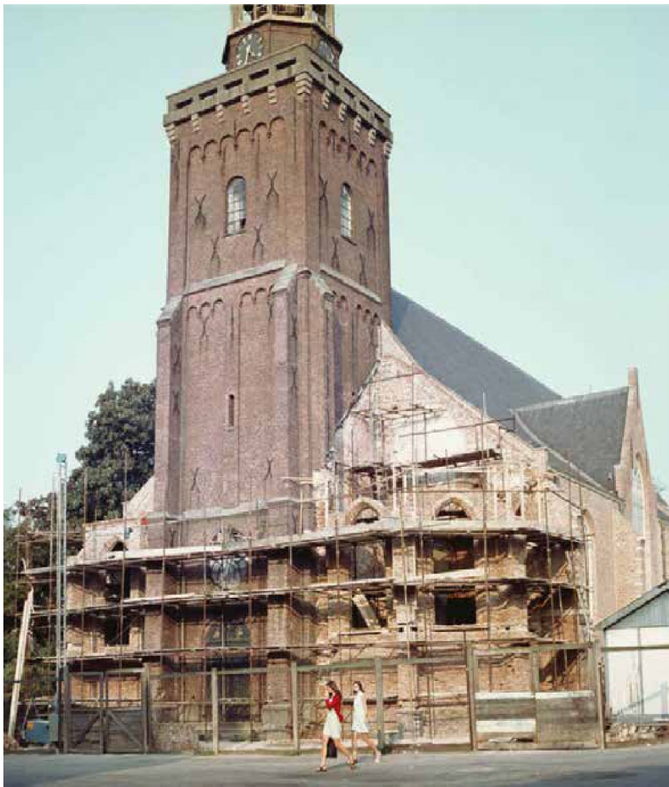
afbeelding 214. Opnieuw opmetselen van de zijbouwen van de toren, ca. 1972. Bron: RHCRL C026, inv.nr.: X3787.
