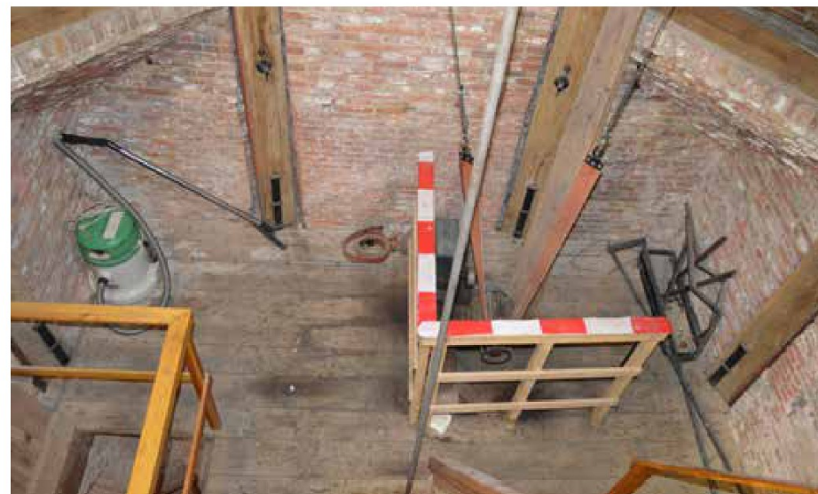
afbeelding 66. De houtconstructie van de torenvoet (1972-73).
