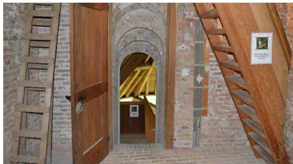
afbeelding 56. De balklaag van de 2de verdiepingvloer in de toren (1972-73).
