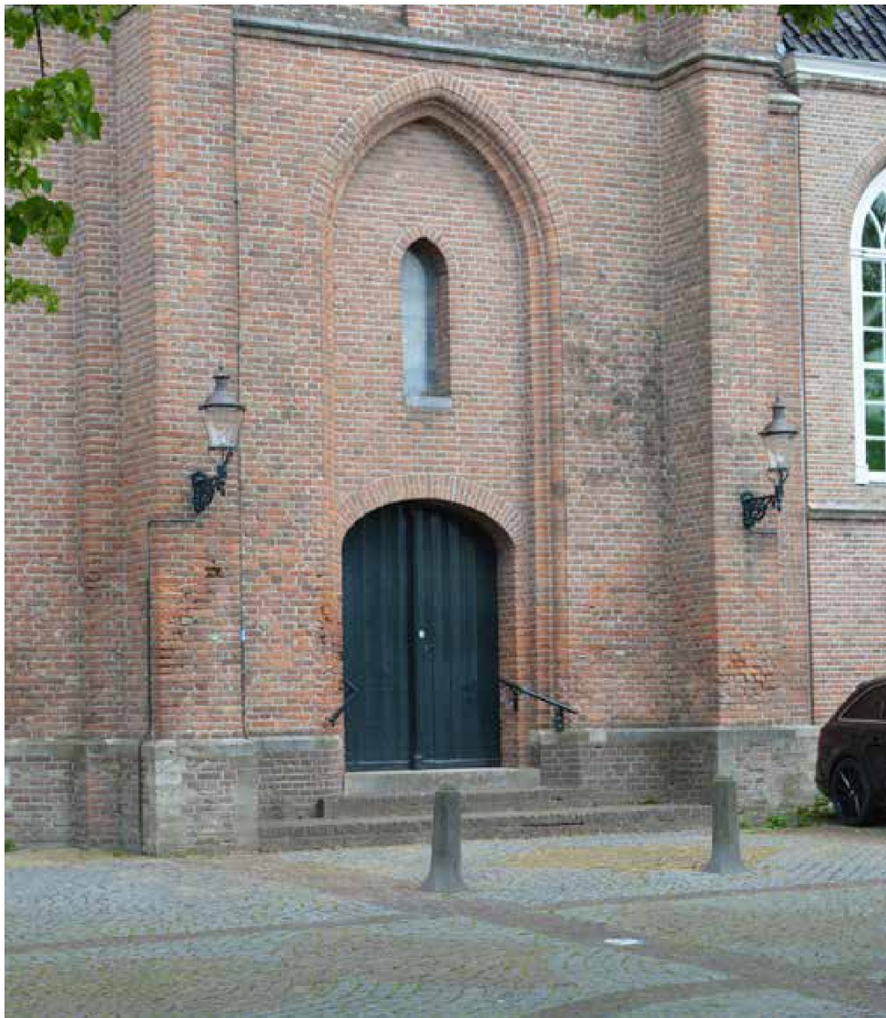
afbeelding 10. De westelijke entree ter plaatse van de toren. De geprofileerde spitboogvormige nis met klein spitsboogvenster en de dubbele deur onder een gedrukte boog kwamen alle gedurende de restauratie van 1972-73 tot stand.
