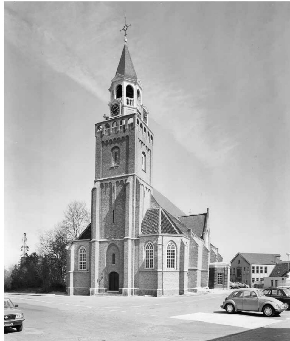
afbeelding 219. Hervormde kerk vanuit het zuidwesten na de restauratie, maart 1978, door G.J. Dukker. Bron: RCE, doc.nr. 198170.
