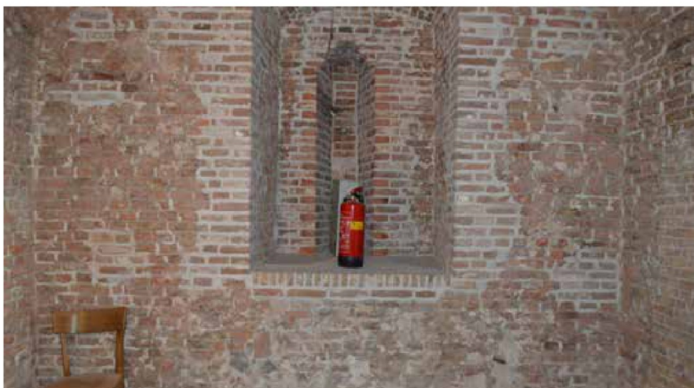
afbeelding 58. De zuidgevel van de toren op de eerste verdieping (in twee delen). De verdikking in de muur (stippellijn) en bouwsporen van een voormalige balklaag (pijlen) duiden erop dat de tweede verdiepingvloer van de toren oorspronkelijk lager lag.
