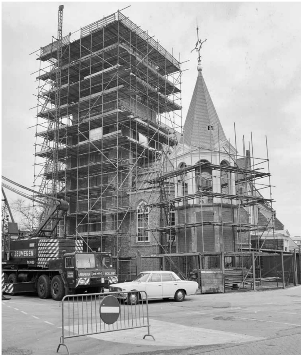
afbeelding 218. Plaatsing van de nieuwe torenspits in april 1973, onderworpen door [redacted]. De zijbeuken van de toren zijn net gevoegd en steken witter af. Bron: RCE, doc.nr. 152.366.
