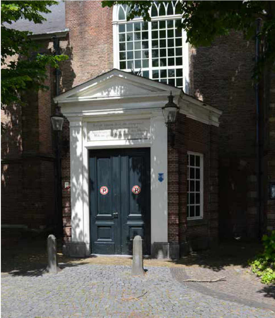
afbeelding 16. Het zeskantige entreepaviljoen (XVIIIld) tegen de middentravee van het schip, met gebosseerde pilasters op de hoeken. Het deurportaal bevat een gepilasterde omlijsting met een frontonbekroning (XVIIIld). Boven de deur is een spreukbord aangebracht.
