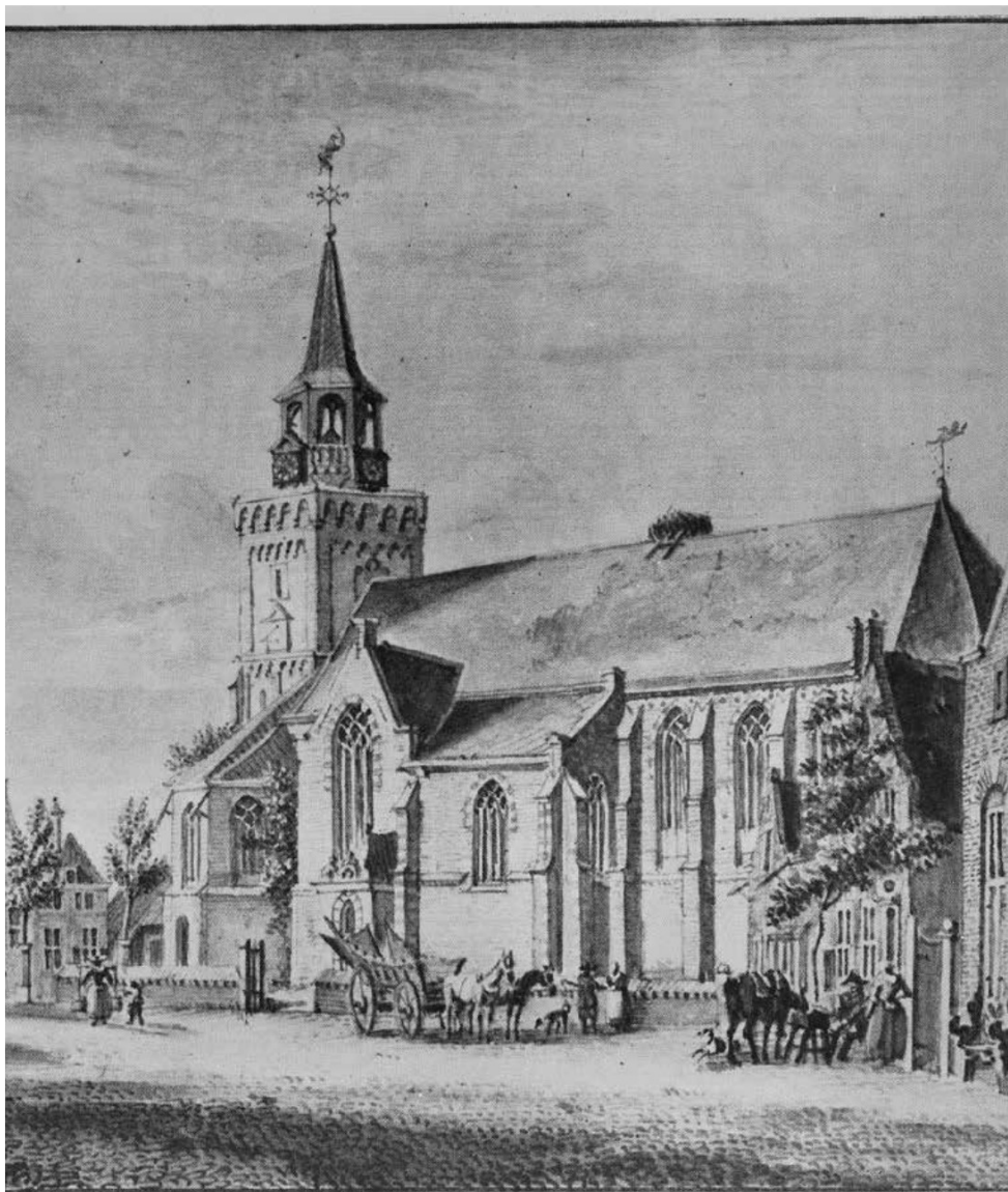
afbeelding 176. Fragment van de St. Galluskerk, gezien vanuit het zuidoosten. Tekening van de Dorpsstraat te Bodegraven door Jan de Beijer, 1757. Bron: RCE, doc.nr. 36.505.
