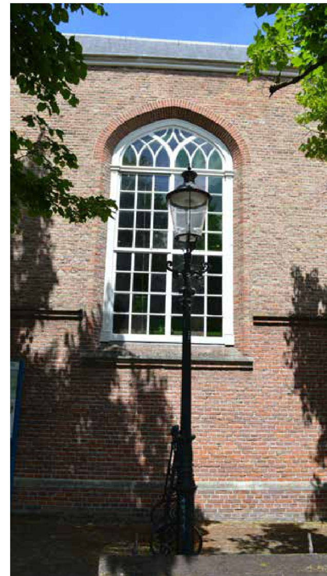
afbeelding 21. De oostelijke travee van het schip; in 1968-71 opnieuw opgetrokken en voorzien van huidige plint, lijsten en venster.
