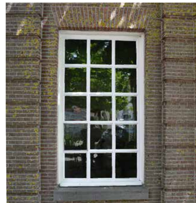
afbeelding 15. Twee details uit de volgende afbeelding van het entrepaviljoen aan de zuidgevel (XVIIIId). Boven: de puntige zinken dakpijon op de daknok, onder: venster 3 x 5 ruits raam onder een gemetselde hanekam.
