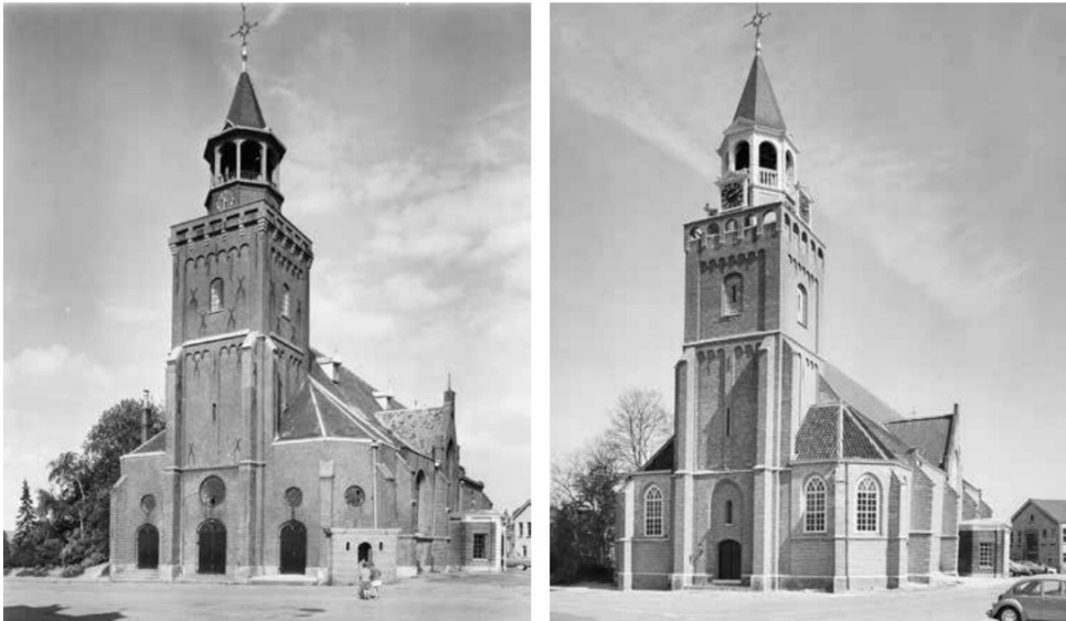
afbeelding 164. De Dorpskerk vanuit het zuidwesten, in 1961 voor de restauratie en in 1978 na de restauratie. De gevelgeleding en torenspits werden gewijzigd, ook werden de zijbeuken van de toren geheel opnieuw opgetrokken. Bron: RCE, doc. nr. 60.983, 198.170.
