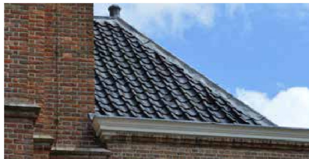
afbeelding 8. Zuidelijke zijbouw van de kerktoeren; geheel opnieuw opgetrokken gedurende de restauratie van 1972-73. De houten vensters met traceringen en de zijdeur werden toen voorzien. Het dak is gedekt met linksdekkende blauwe geglazuurde pannen.
