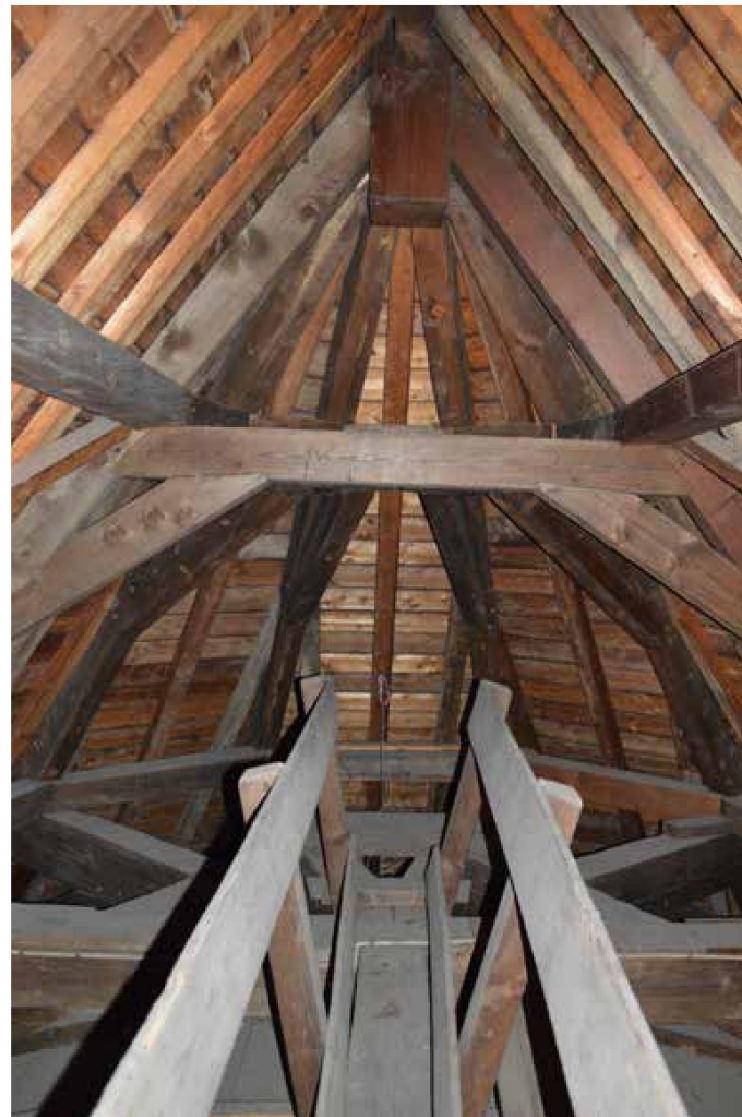
afbeelding 133. De kapconstructie boven het koor (1674), gezien richting het oosten. Op de voorgrond het kopse gebint ter plaatse van de koorafsluiting (oost), aansluitend op vier halfspanten. De gordingen en beschot werden vernieuwd (1968-71).
