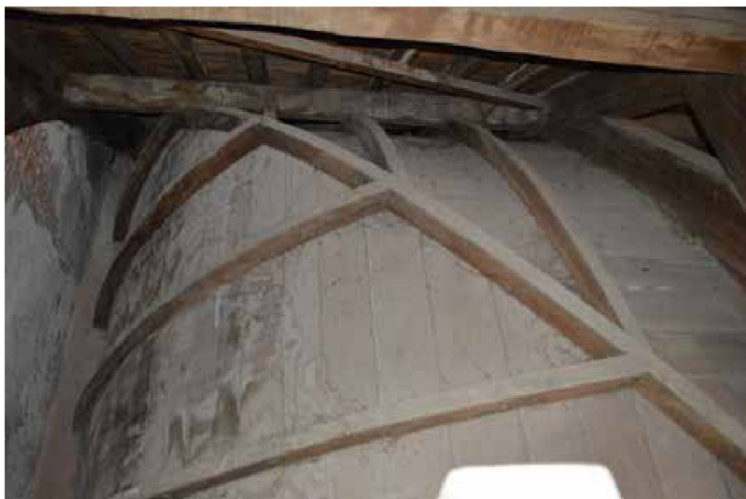
afbeelding 139. De westzijde van de kap, met de muur van de toren en toegang tot de kapconstructie.
