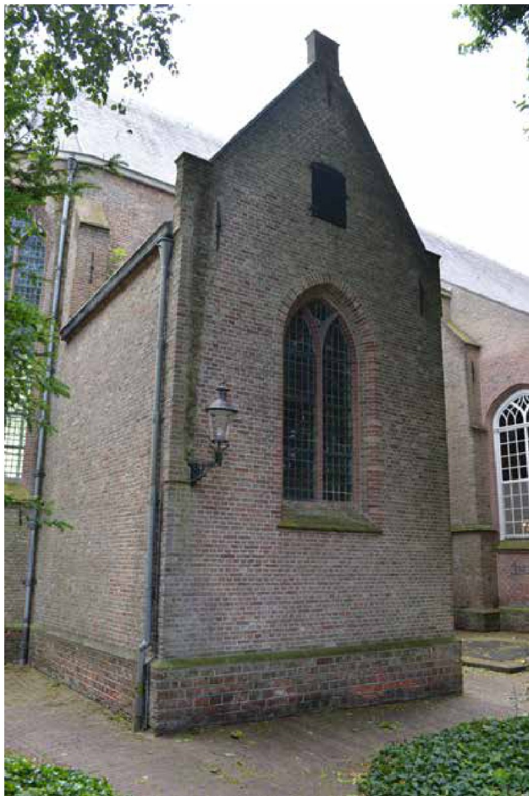
afbeelding 30. De aangebouwde sacristie aan het koor met tuitgevel uit 1968-1971.
