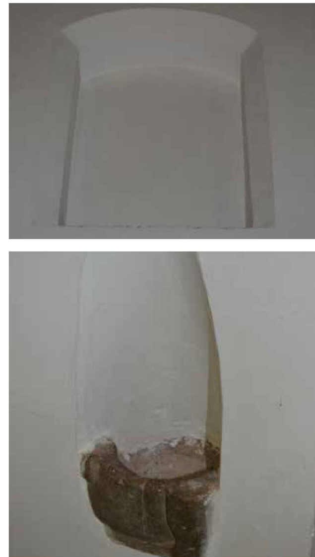
afbeelding 104. Detail uit eerdere afbeelding van het hooggeplaatste dichtgezette venster. afbeelding 105. Muurnis voor wijwater.
