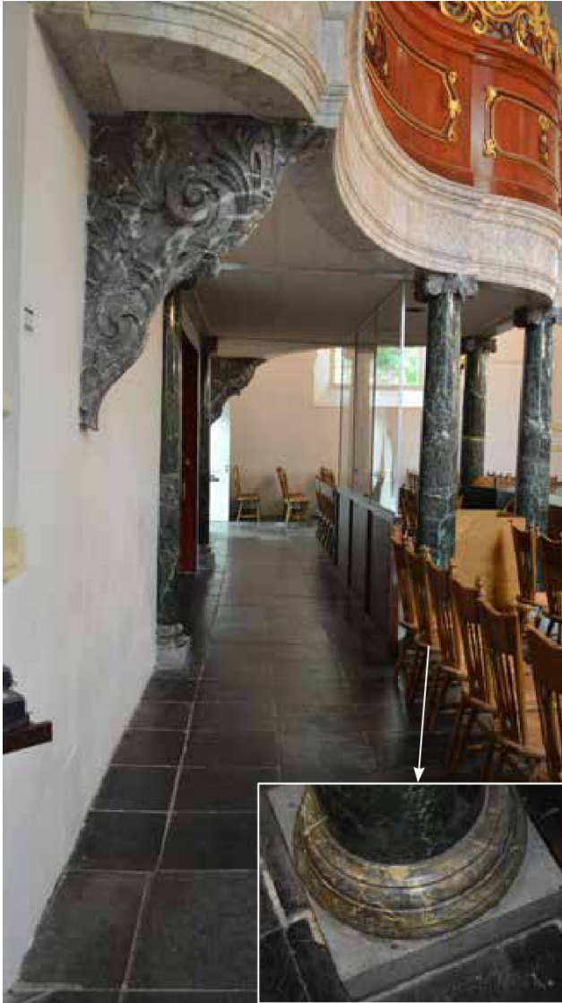
afbeelding 117. De onderzijde van de orgelgalerij gezien richting het noorden. De galerij steunt op vier hele en twee halve gemarmerde kolommen en twee muurconsoles.
