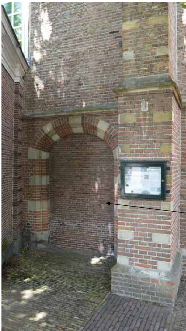
afbeelding 19. Blindnis met gemetselde, geprofileerde omlijsting met ingewerkte zandsteenblokken, gerealiseerd in 1968-71. De steunbeer werd in 1968-71 opnieuw opgemetseld en tevens voorzien van zandsteenblokken.
