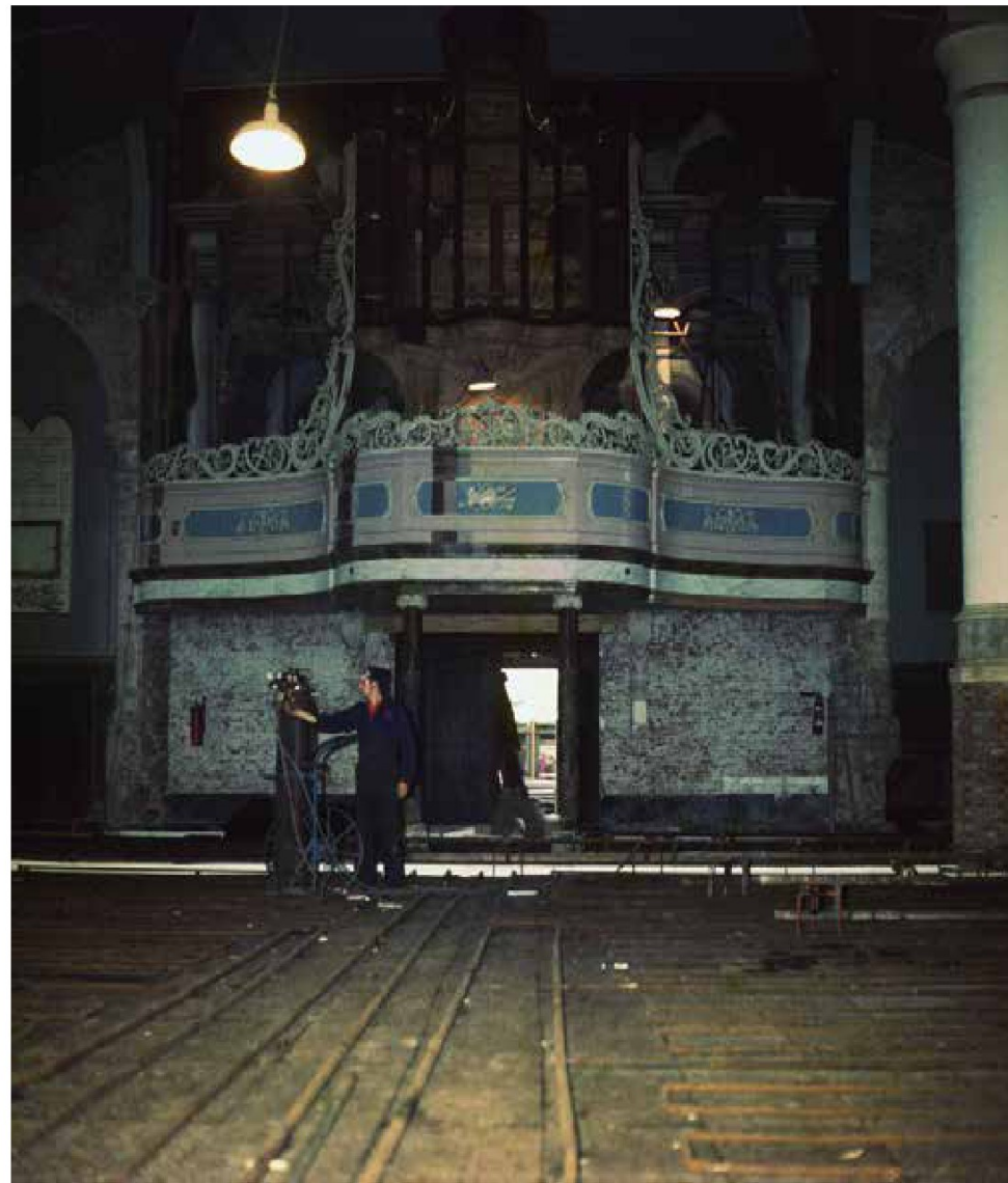
afbeelding 213. Aanleg van de vloerverwarming, gedurende de restauratie, 1968-1971. Bron: RHCRL C026, inv.nr.: X3804.
