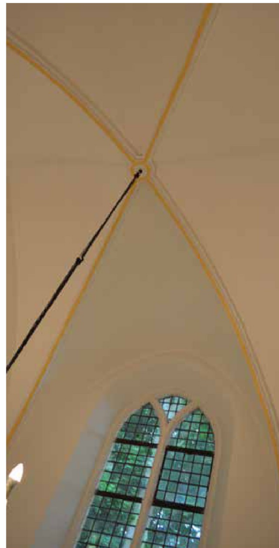
afbeelding 146. Plafond: uitgewerkt als kruisribgewelf met gemetselde ribben op aanzetstenen (rechts, 1968-71).
