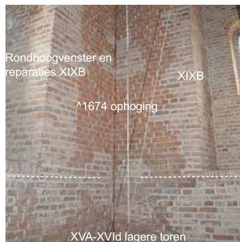
afbeelding 63. Zicht omhoog ter plaatse van de zuidgevel van de derde geleding van de toren. De grotere segmentboogvormige opening werd in dichtgemetseld (1971-72) en voorzien van een spleetvenster met ronde bovenzijde (1972-73). Vanaf de onderdorpel van de openingen wijkt het metselwerk van de toren af (zie onder).
