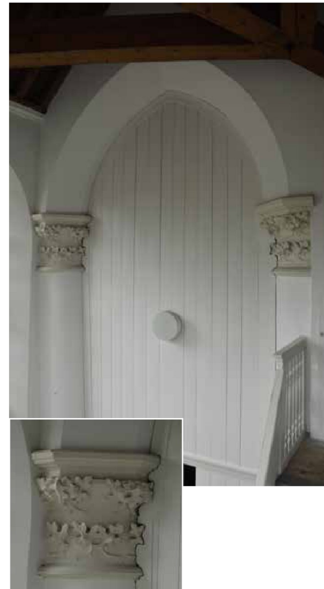
afbeelding 47. Spitsboog met halfkolommen (XVIA), waartussen een schot werd geplaatst. De bladkapitelen werden in 1968-1973 gereconstrueerd.
