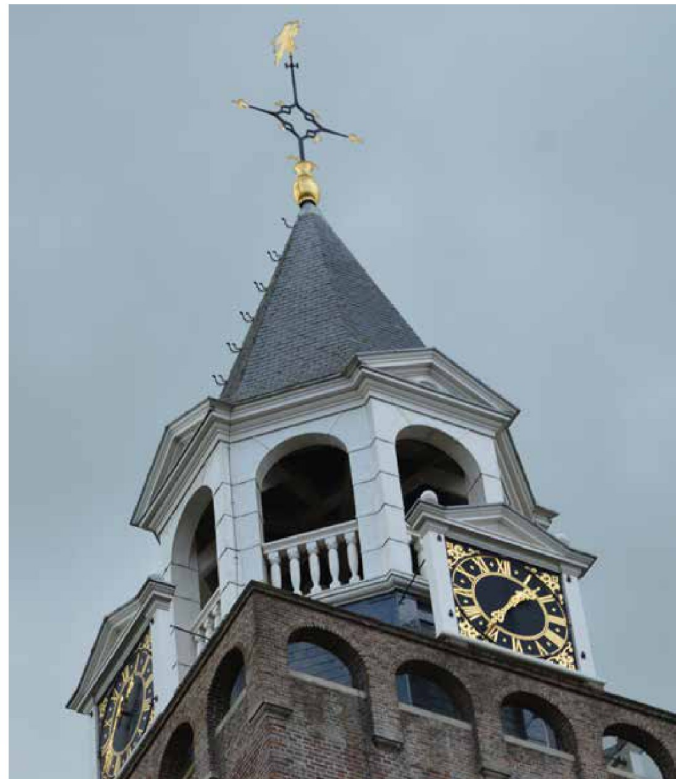
afbeelding 42. De spits, gezien vanaf het maaiveld vanuit het noordoosten. Op de spits uit 1972-73 werden leien voorzien in maasdekking. De windroos werd bekroond met een vergulde leeuw.
