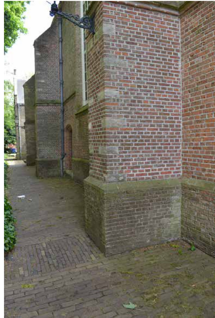
afbeelding 29. Zicht langs de noordgevel richting het oosten.
