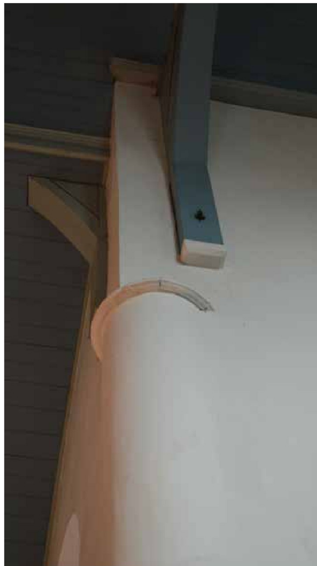
afbeelding 84. De noordelijke vieringpijler tussen koor en schip.
