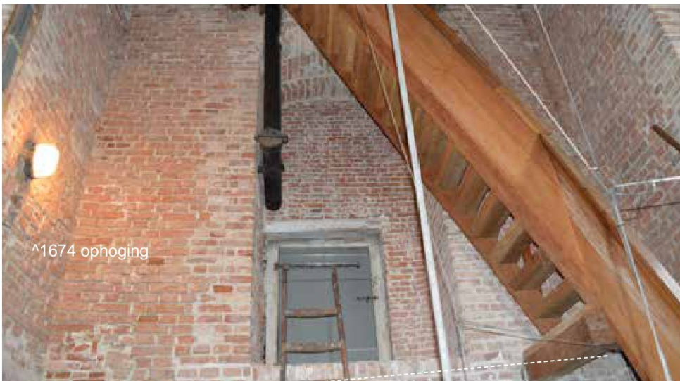
afbeelding 60. De balklaag van de 3de verdiepingsvloer in de toren (1972-73).
