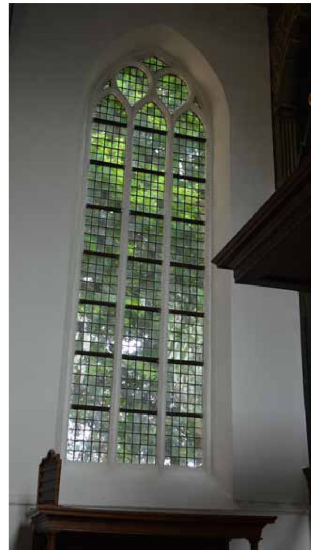
afbeelding 85. Venster in de noordgevel van het koor. Dit venster werd geheel in 1968-71 gerealiseerd ter plaatse van een bestaand dichtgezet koorvenster.
