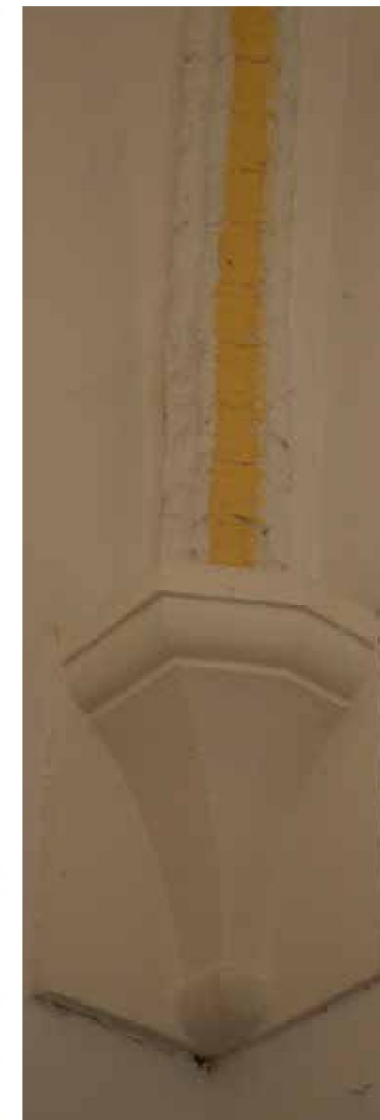
afbeelding 146. Plafond: uitgewerkt als kruisribgewelf met gemetselde ribben op aanzetstenen (rechts, 1968-71).
