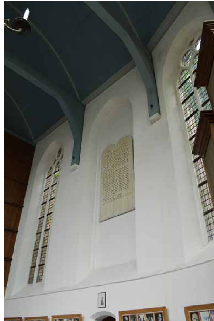
afbeelding 124. Het koor, gezien langs de noordmuur. Ter plaatse van de aangebouwde sacristie uit 1968-71 bleef de spitsboogvormige nis hier gesloten. In de nis is een beschilderd tekstbord geplaatst 'vervolg der lotgevallen van Bodegraven.'
