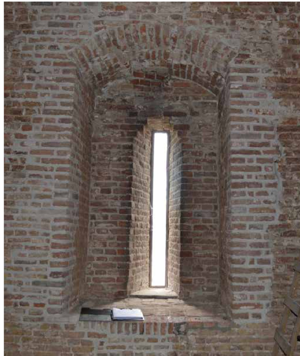
afbeelding 59. Venster in de voorgevel (west) van tweede geleding van de toren. De grotere segmentboogvormige opening werd in dichtgemetseld en voorzien van een spleetvenster. Steenformaat inboeting: 18 \times 8,5-9 \times 4 \text{ cm} 10 lm = 50 cm.
