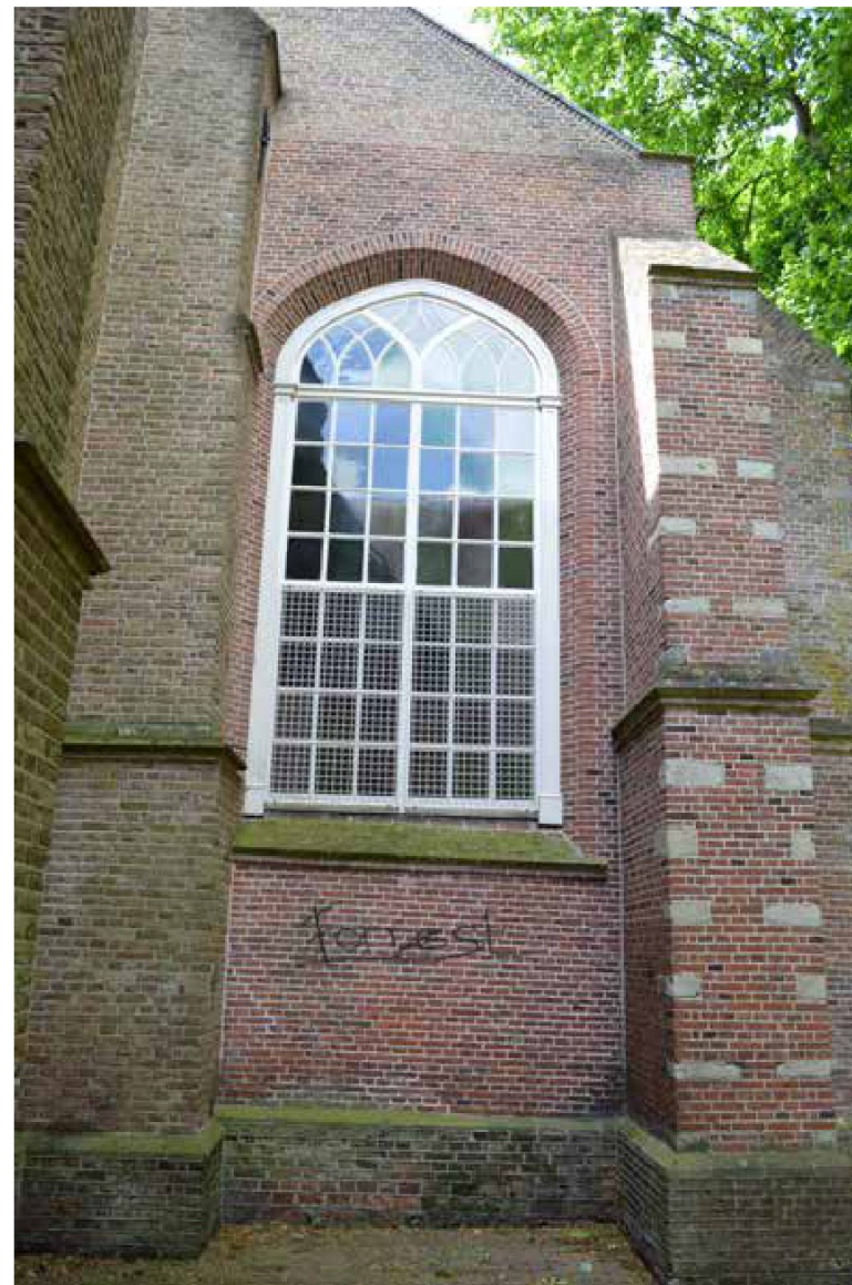
afbeelding 31. De oostmuur van het schip, bestaande uit een roder metselwerk (19 x 9 x 4 cm met tienlagenmaat 49).
