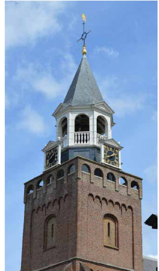
afbeelding 9. De torenspits, gezien vanuit het zuidwesten. De borstwerking van de omloop met rondbogen werd in 1972-73 opgetrokken. De gehele torenspits dateert uit deze restauratie, eveneens werden toen de torenramen dichtgemetseld en voorzien van een smalle kikspleten.
