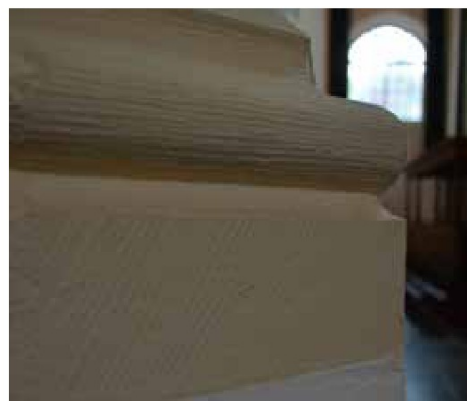
afbeelding 99. Detail van het achthoekige basement van de zuidwestelijke pijler. In 1968-71 hersteld, opnieuw bepleisterd (plaatselijk gekamd, zie onder).
