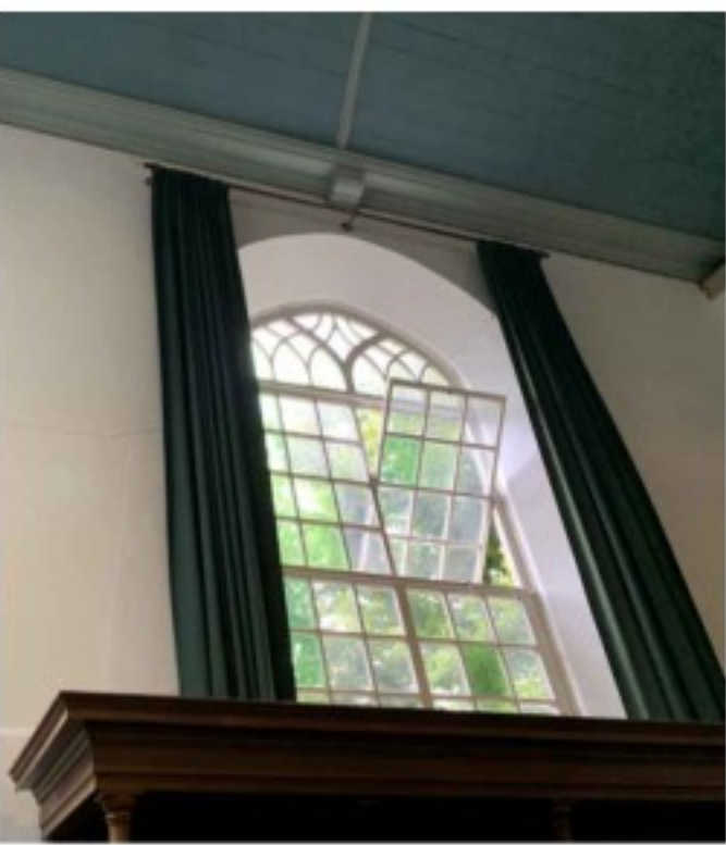
Foto kozijnmerk 1b (bestaand)
