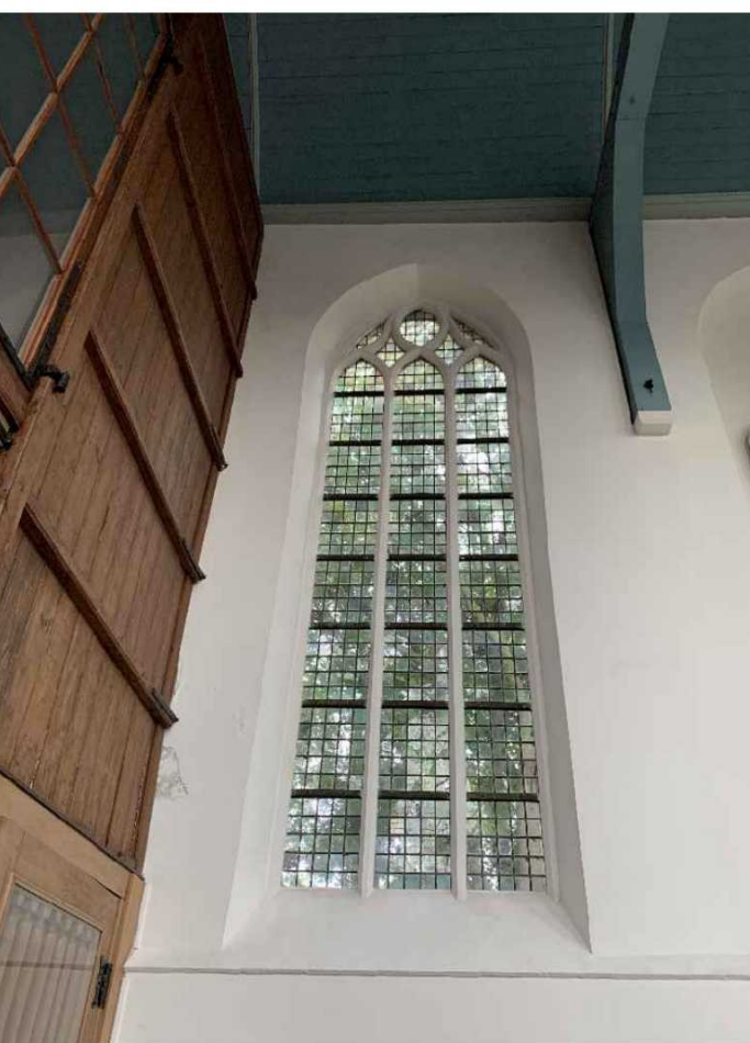
Foto dagkanten kozijnmerk 3
