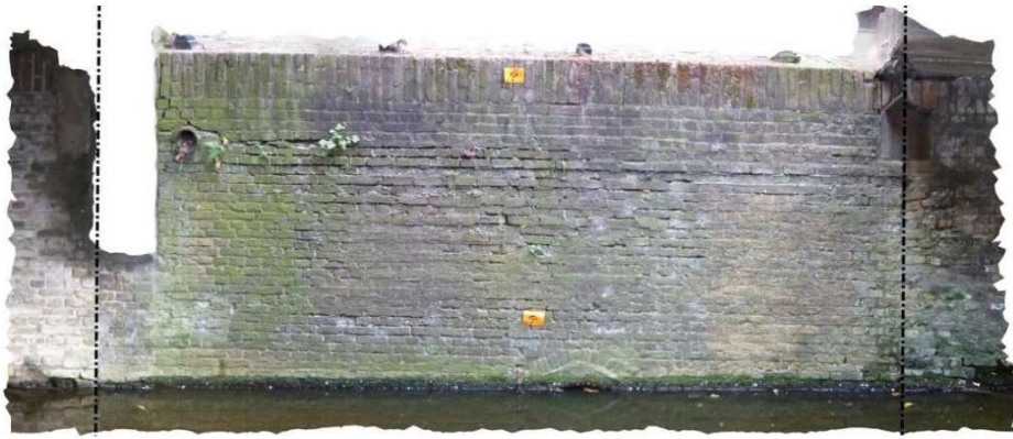
Sectie 9, het metselwerk tussen overkluizing en de Kapelbrug.
