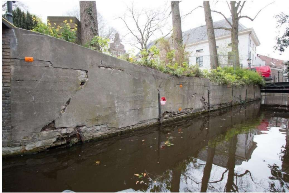
Sectie 6, gebouwd in 1707 (bestek) en voorzien van een aantal staafankers.
