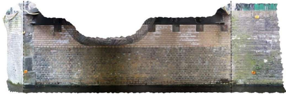
Zichtbaar metselwerk onder de Koorbrug is uit de twintigste en eenentwintigste eeuw.
