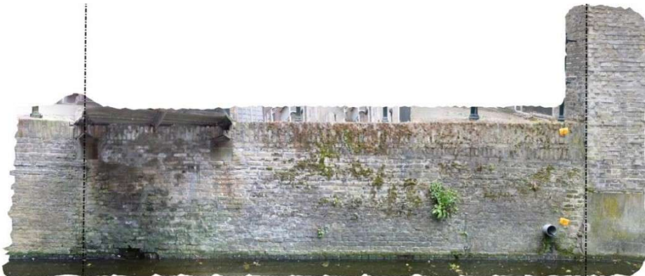
Metselwerk van de laatste sectie, vanaf de Kapelbrug in noordelijke richting.
