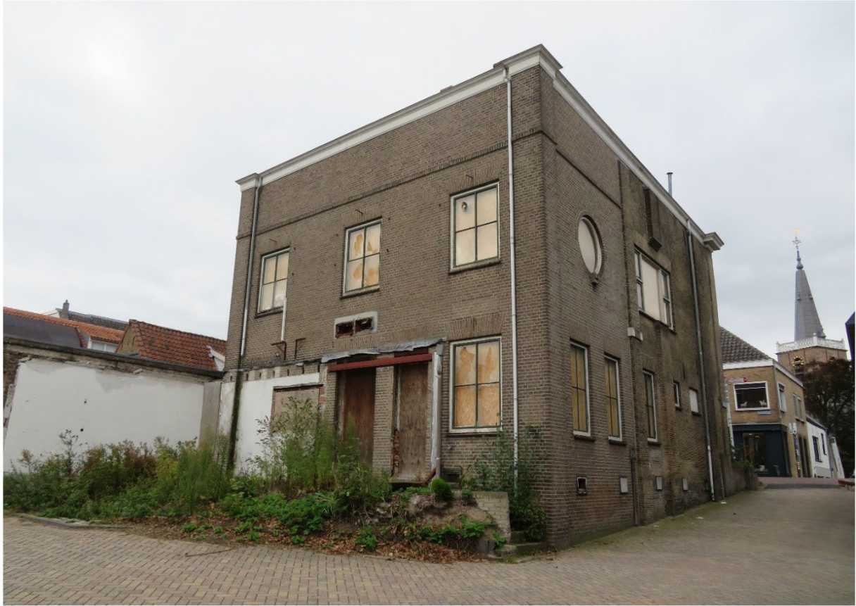
Achtergevel (zuidoost), aan de Hollandse IJssel en de linker zijgevel, aan de Veerstoep
