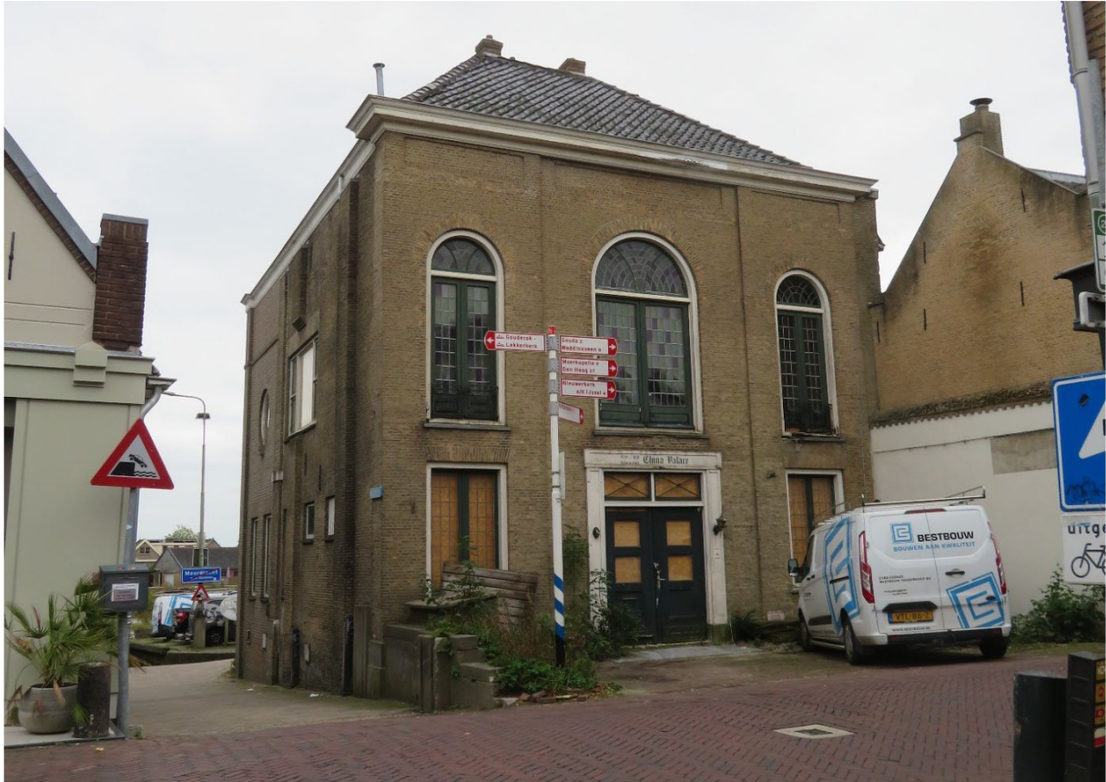
Linker zijgevel (noordoost) aan de Veerstoep en voorgevel (noordwest) aan de Dorpsstraat
