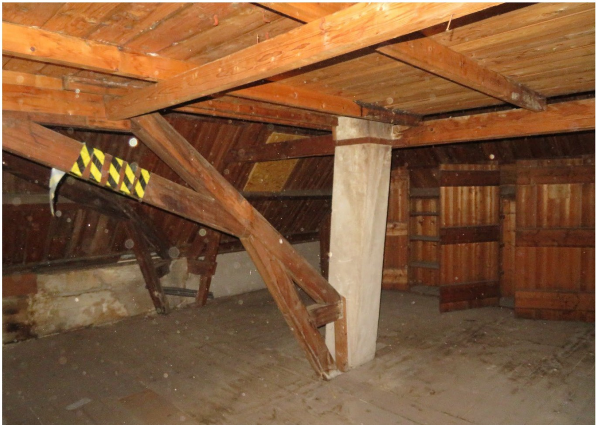
Zolder, kijkend richting linker zijgevel en achtergevel
