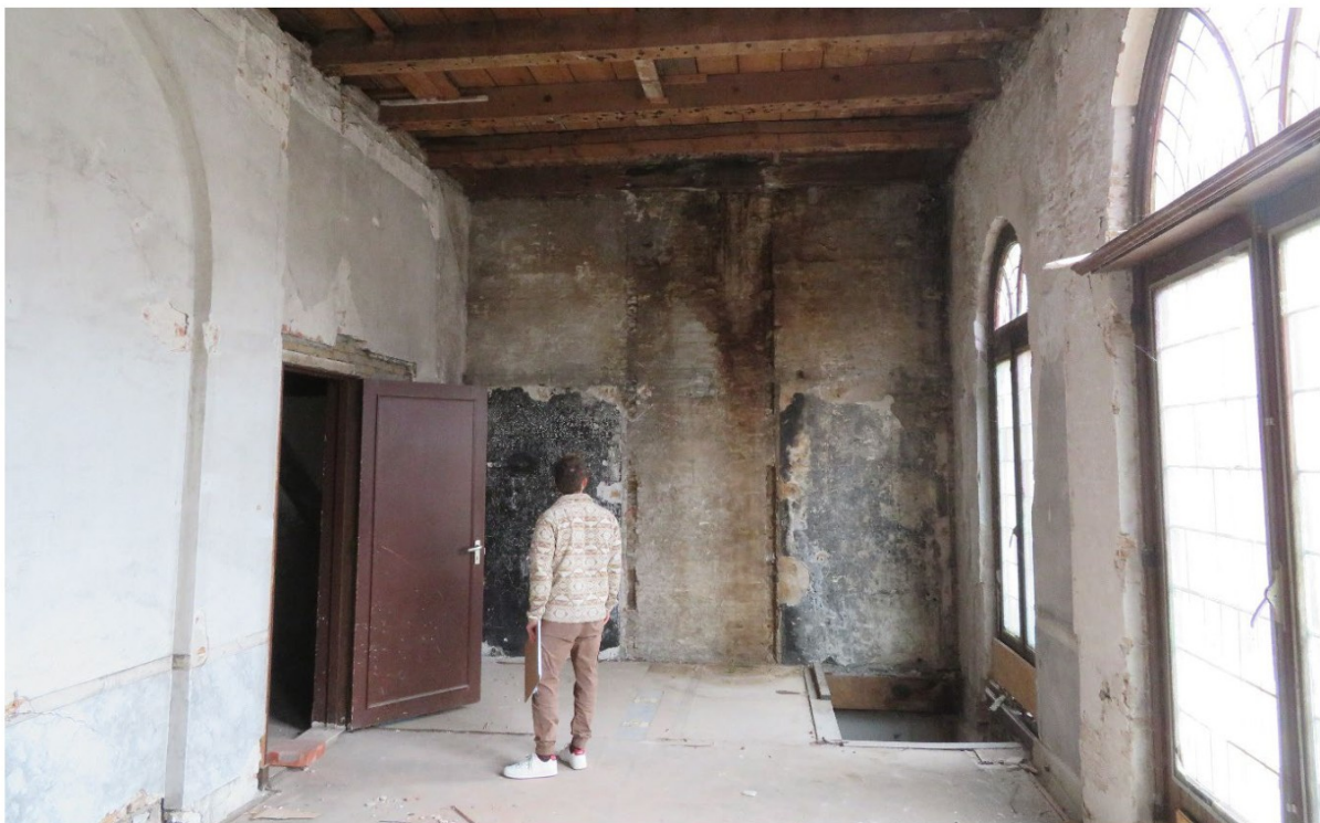
Voorruimte 1 e verdieping – voormalige raadszaal richting rechter zijgevel
