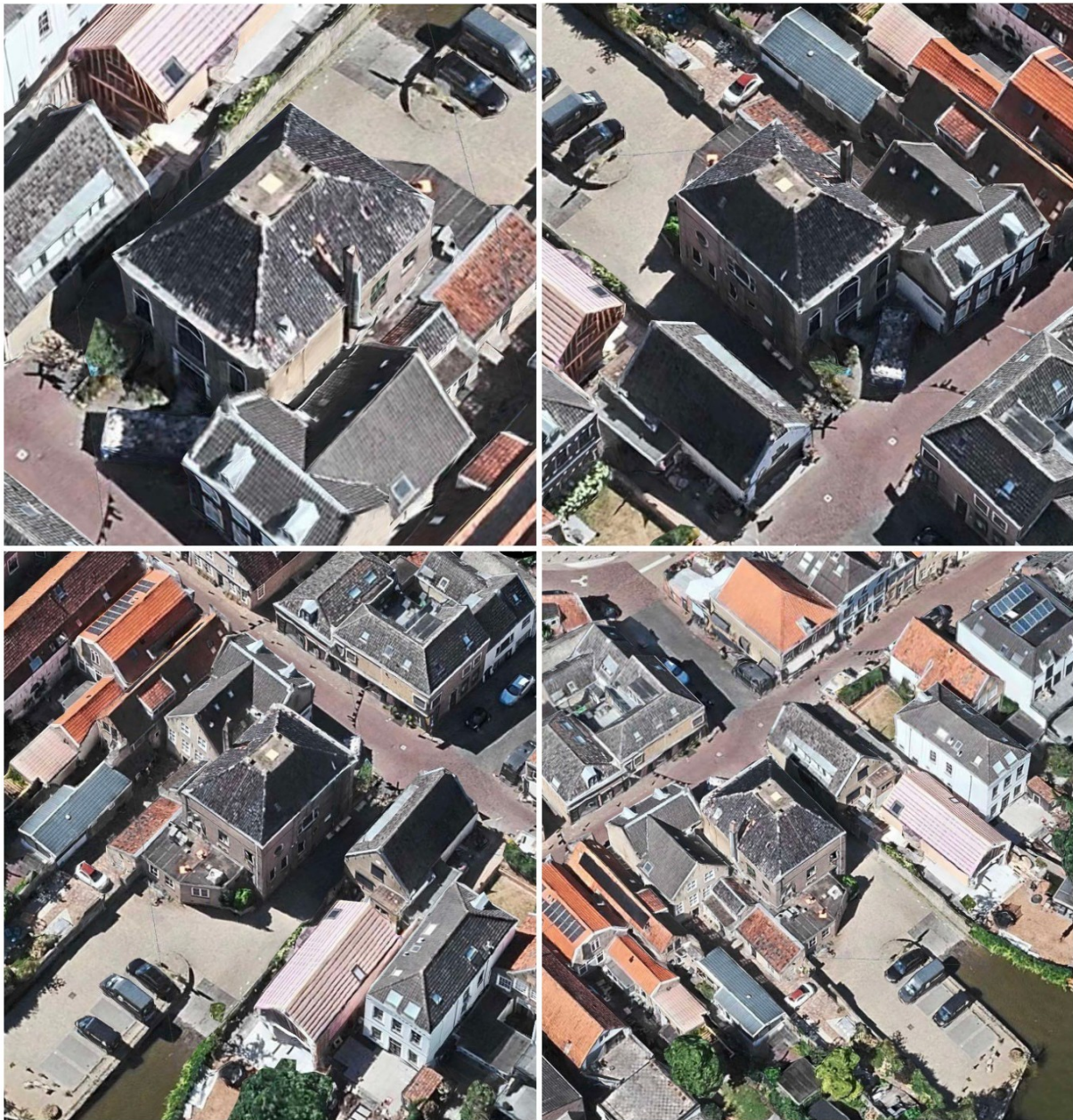
Overzicht (Apple Maps) van de situatie (voor de sloop van de aanbouw tegen de achtergevel).
