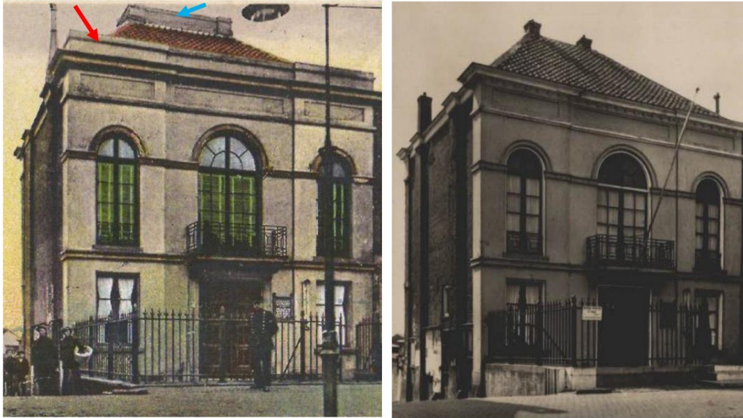
Figuur 2: Links: het raadhuis, op de hoek van de Dorpsstraat en de Veerkade, voor het verwijderen van de cordonlijst (rode pijl) en de boeilijst (blauwe pijl). Rechts de aangepaste situatie. (HVM).
