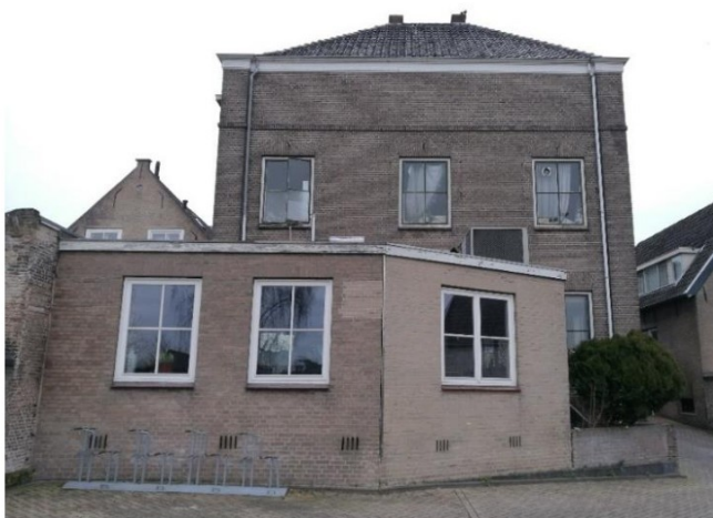
Figuur 6: Opname van de achtergevel.
