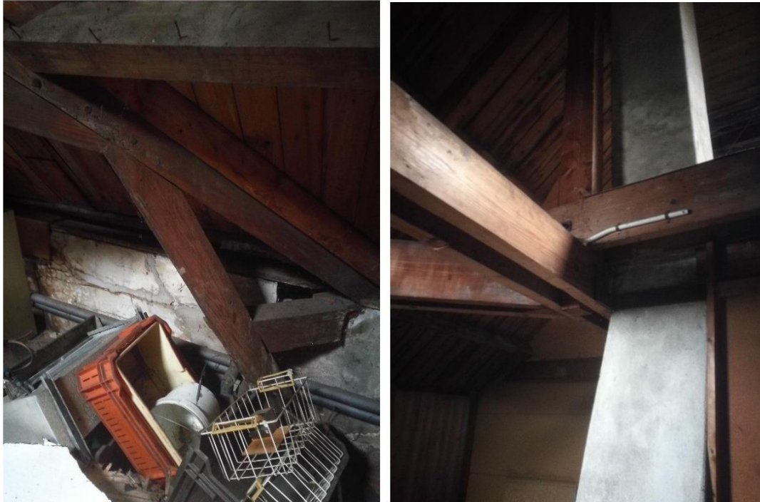
Figuur 16: Links: constructiedetail van één van de oorspronkelijke spanten. Rechts de constructiewijze boven de uitbreiding.
