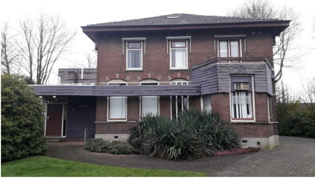
Huidige situatie kantoorgebouw (Bron: Eceau, 4 februari 2022)
