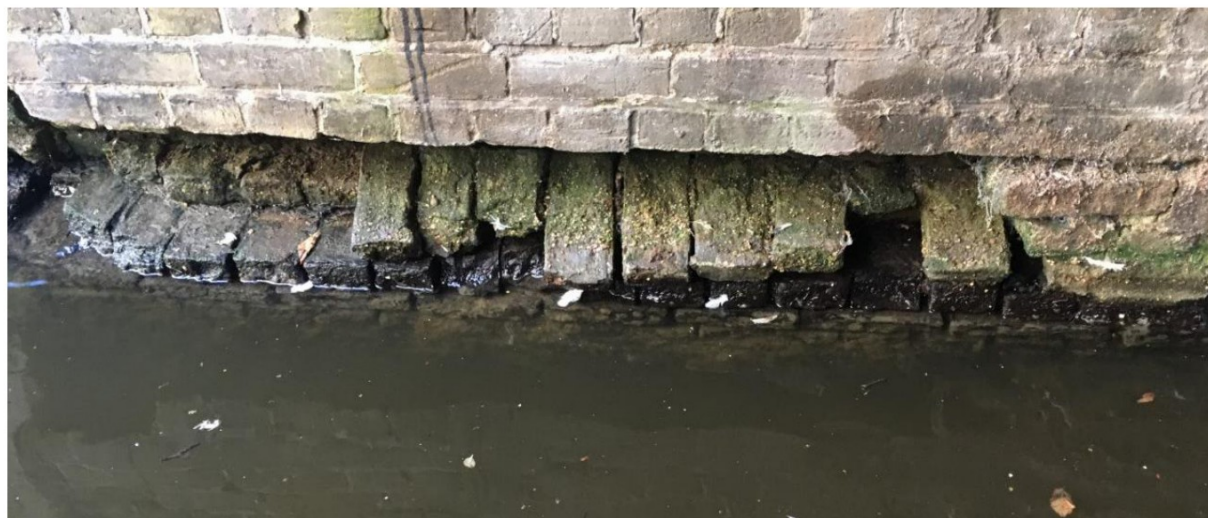
Kademuur/landhoofd onder waterlijn Koorbrug
