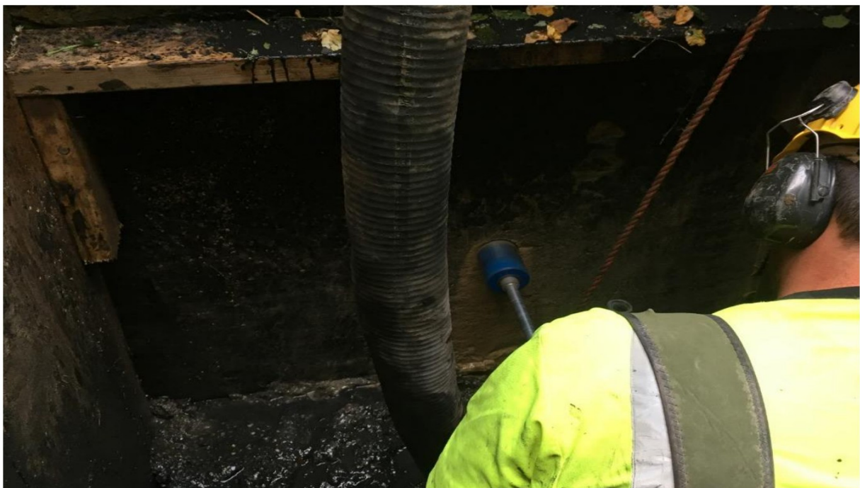
Kademuur onder waterlijn proefkuip 2
