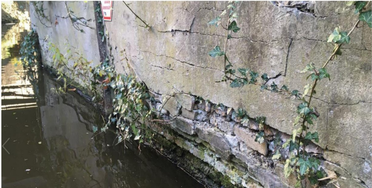
Kademuur zuidoostzijde Koorbrug
