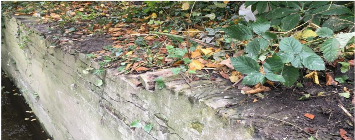
Rollaag oostzijde van Sint Jan tuinzijde
