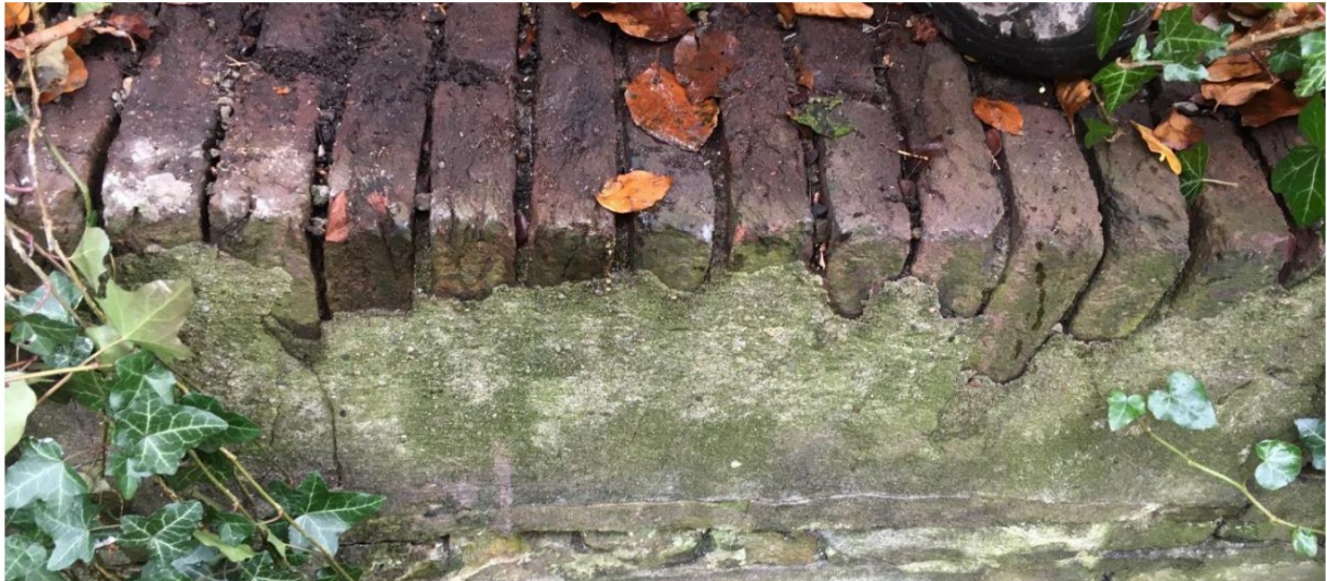
Rollaag oostzijde van Sint Jan tuinzijde
