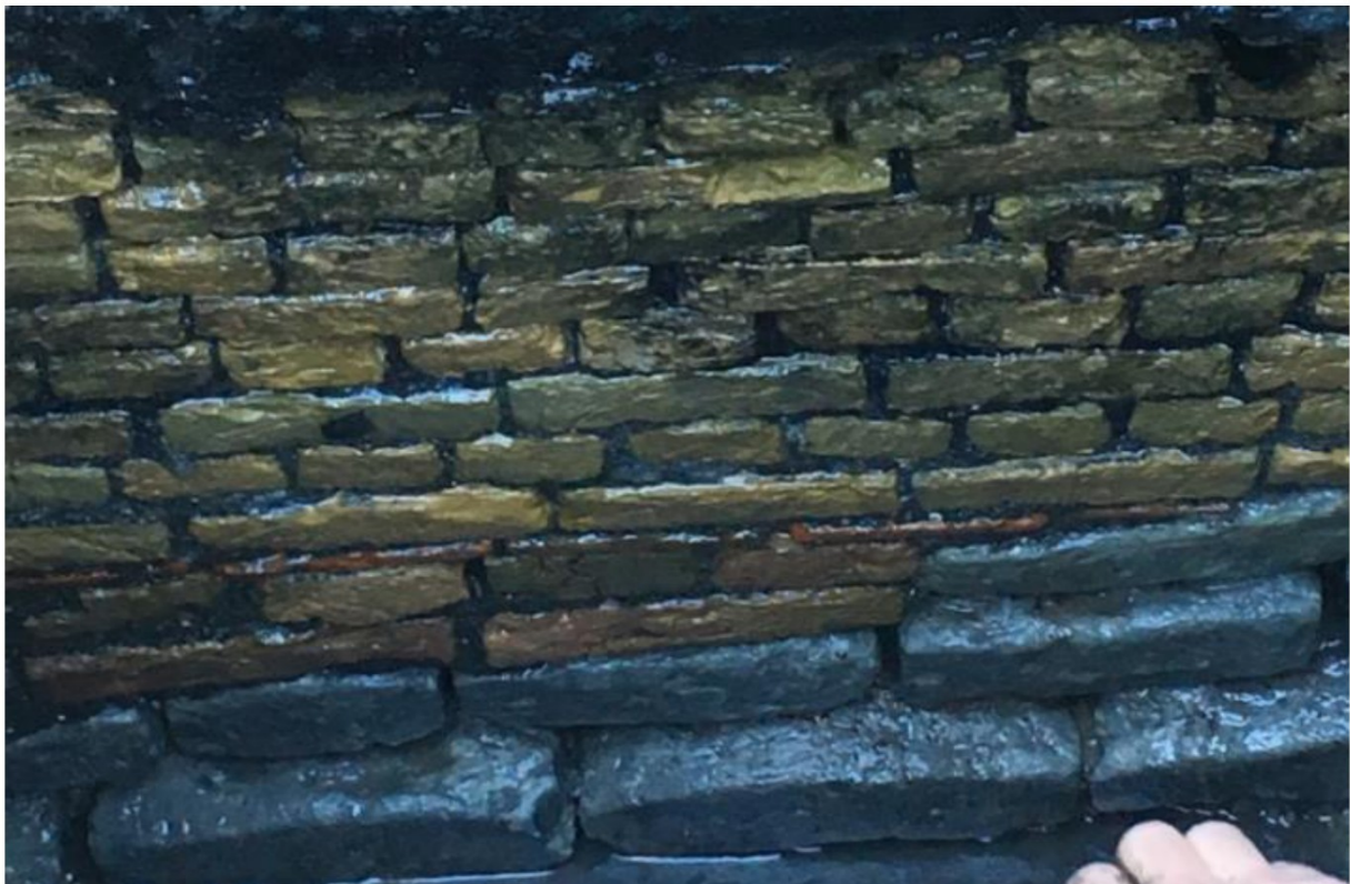
Kademuur onder waterlijn proefkuip 1
