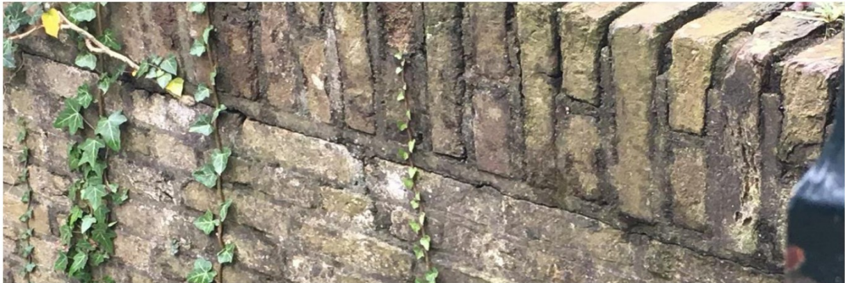
Rollaag thv inspectiekuip 1 (gedeelte tussen Collatiebrug en loopbrug naast kapel).
