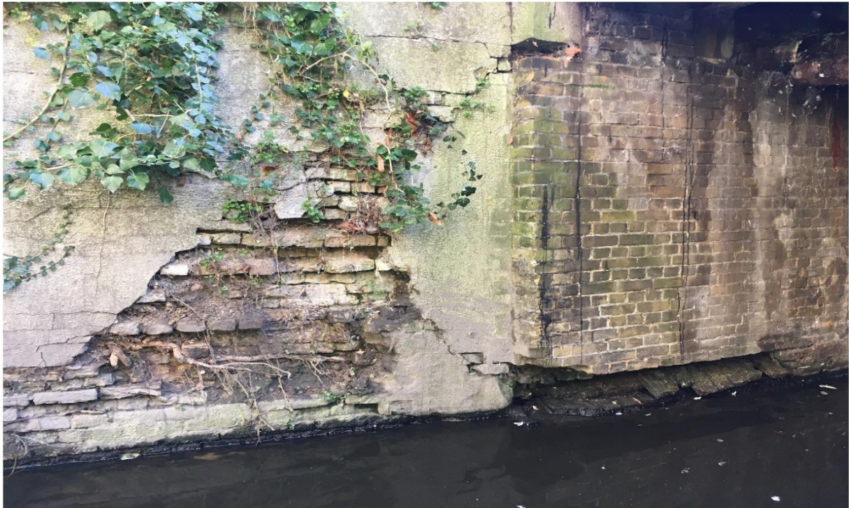
Aansluiting kademuur op noordoostzijde Koorbrug
