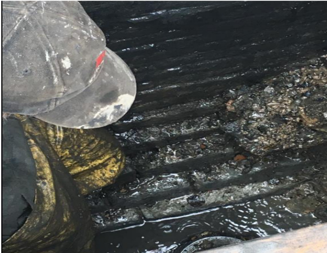
Kademuur onder waterlijn proefkuip 1
