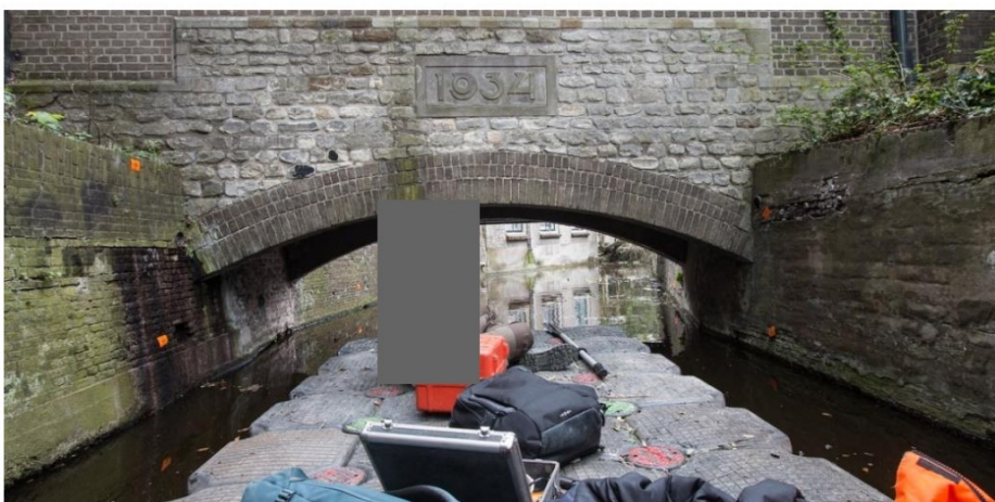
Onderzoek van het muurwerk vanaf een door de gemeente Gouda gefaciliteerd vaartuig. In de achtergrond de Kapeloverkluizing uit 1934.
