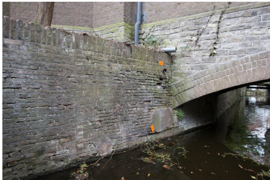
Markering van de plaats van de voorganger van de Kapelbrug in de vorm van twintigste-eeuws metselwerk. Links, moeilijk op de foto te zien, de verticale bouwnaad. De boog is aangebracht onder de overkluizing van gewapend beton.
