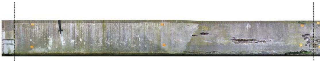
Sectie 1 van de kaaimuur om de Willem Vroesentuin, goeddeels gecementeerd.
