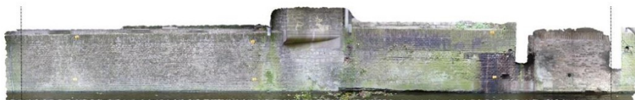
Metselwerk van sectie 8, het metselwerk vanaf de linker steunbeer tot en met de overkluizing.
