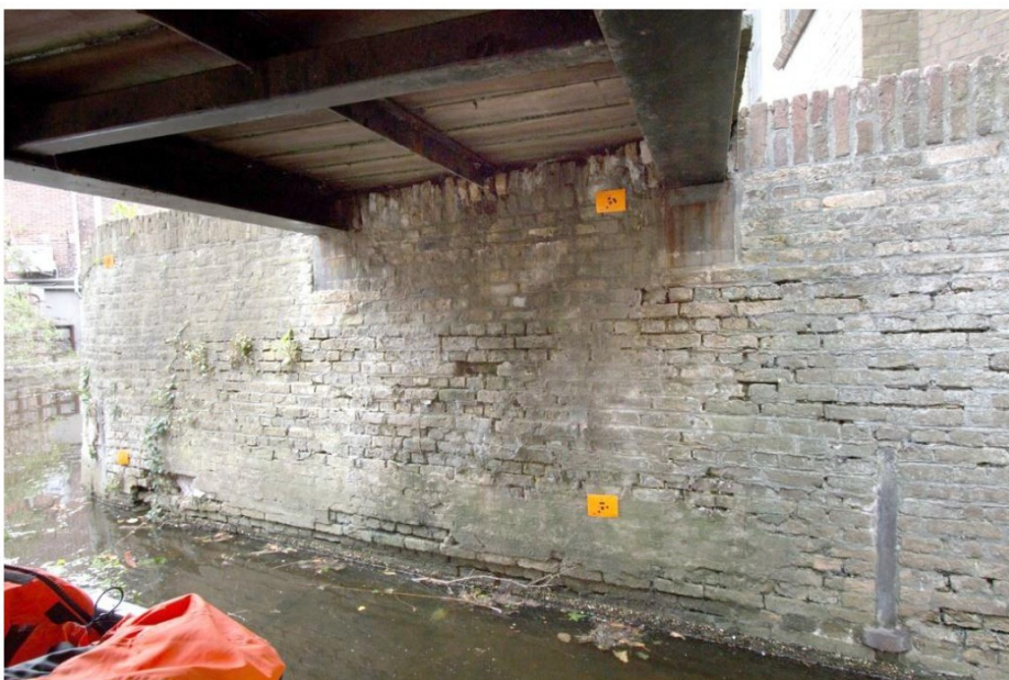
Aansluiting van de Kapelbrug op de kaaimuur. Brugoplegging is gerealiseerd in de bestaande kaaimuur.
