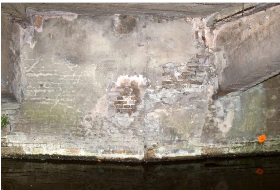
Knik in de muur ter plaatse van de overkluizing. Op de knik sloot vroeger de voorganger van de huidige Kapelbrug aan.
