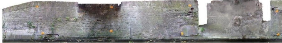
Sectie drie van de kaaimuur met in aanzet de kapelbrug en de inhammen waar de bogen van de overkluizing op de kaaimuur aansluiten.
