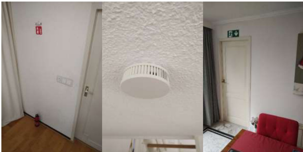
In de woning zijn extra brandblussers en melders geplaatst. Ook is er een vluchtroute markering aangebracht.
