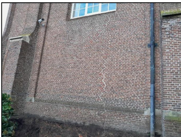
Figuur 4.1 Onderzoekslocatie ter plaatse van het linker raamkozijn
