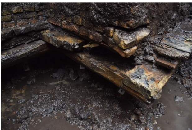
Figuur 5.8 Ontbrekend funderingshout
