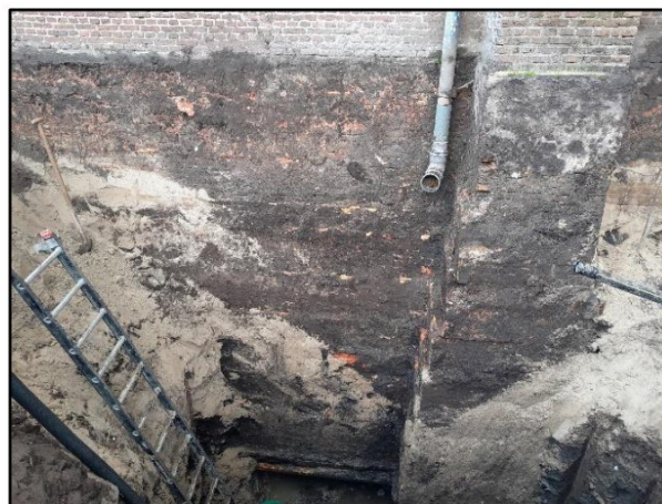
Figuur 4.2 Ontgraving funderingsconstructie rechtsonder het raamkozijn en ter plaatse van de rechter steunbeer
