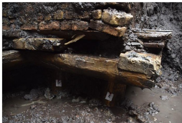
Figuur 5.9 Metselwerk loszittend / verzakt
