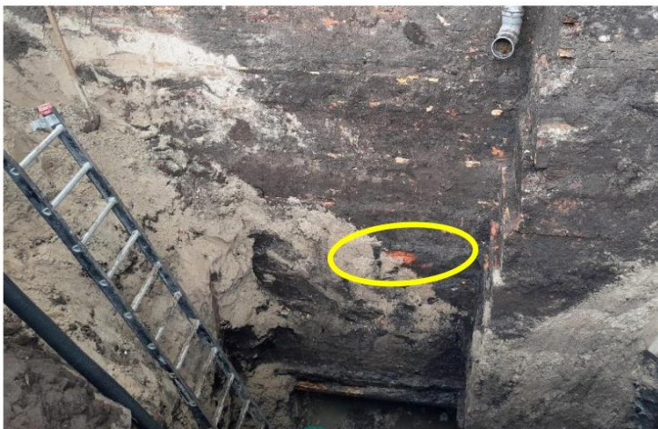
Figuur 5.10 Grondwaterstand tijdens de ontgraving gemarkeerd
