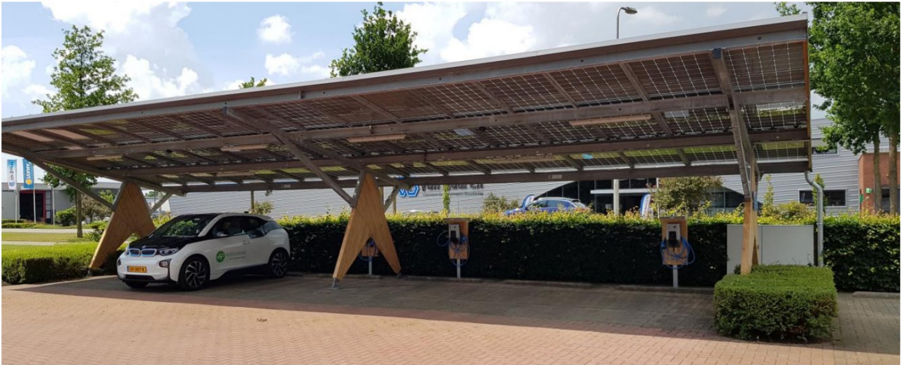
Figuur 6.1 – voorbeeld van een parkeeroverkapping met zonnepanelen en laadpunten
