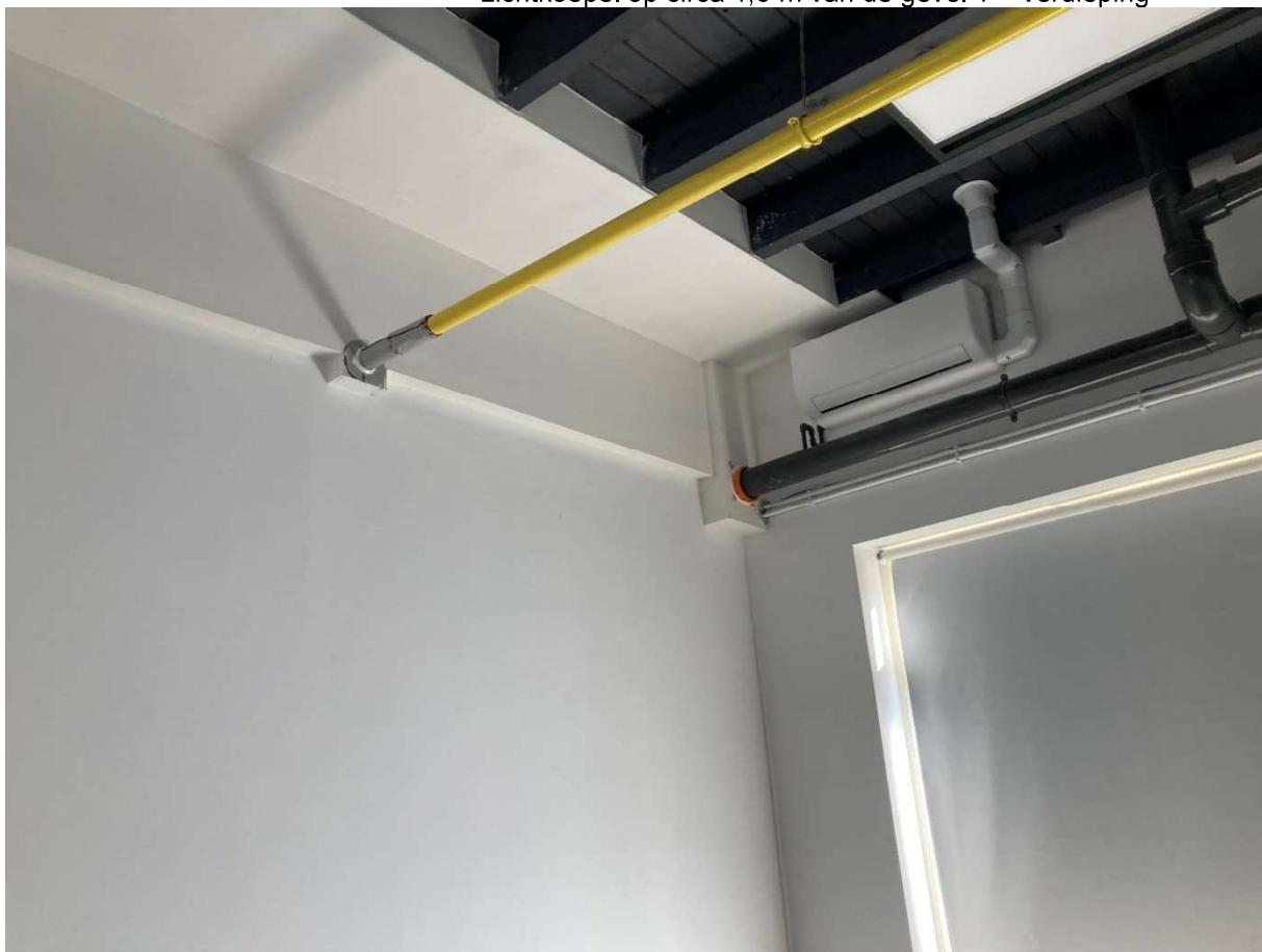
Lichtkoepel op circa 1,5 m van de gevel 1 ste verdieping
