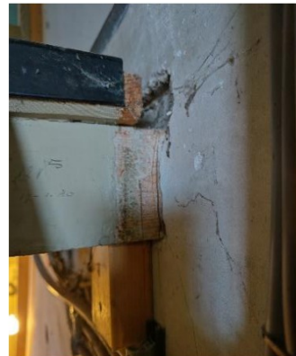
Afb. 2 - Vloerbalken uit de toren getrokken
