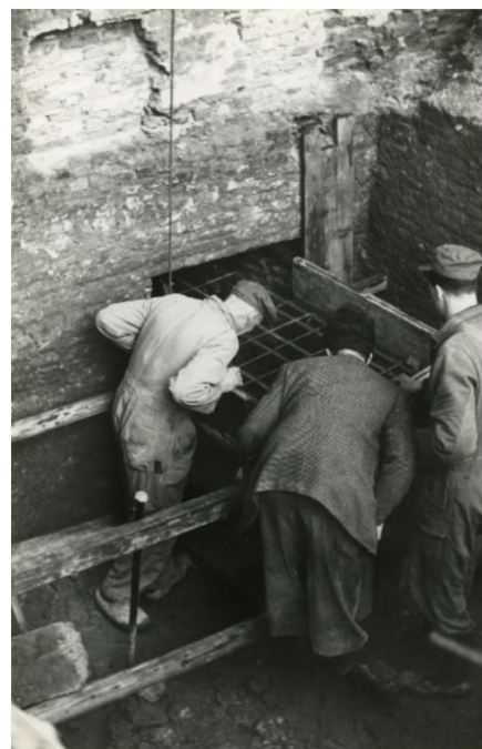
Afb. 3 - Opname van het funderingsherstel uit 1956
