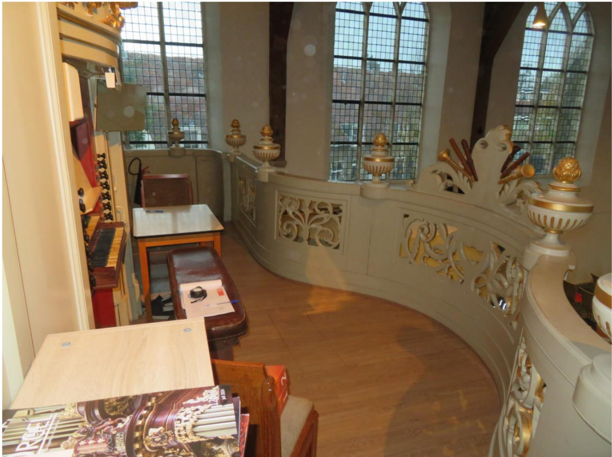
De huidige laminaatvloer, welke zal worden verwijderd en rondom de stalen ligger kan worden teruggebracht (of vervangen door een nieuwe planken afwerking). Aanpassingen aan de kas en balustraden zijn niet wenselijk.
