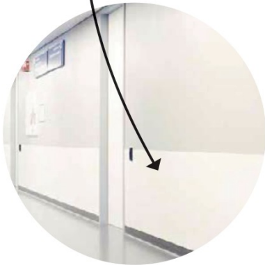
kunststof plaatmateriaal in de gangen
