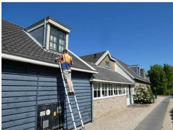
Figuur 13 Onderzoek naar ruimte onder de dakpannen
