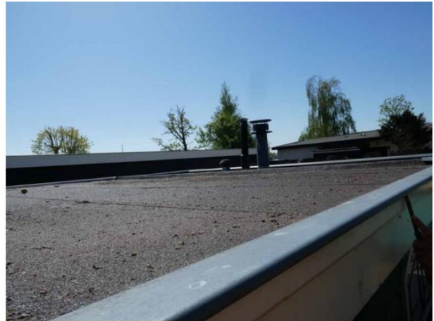
Figuur 20 Het platte dak van de schuur
