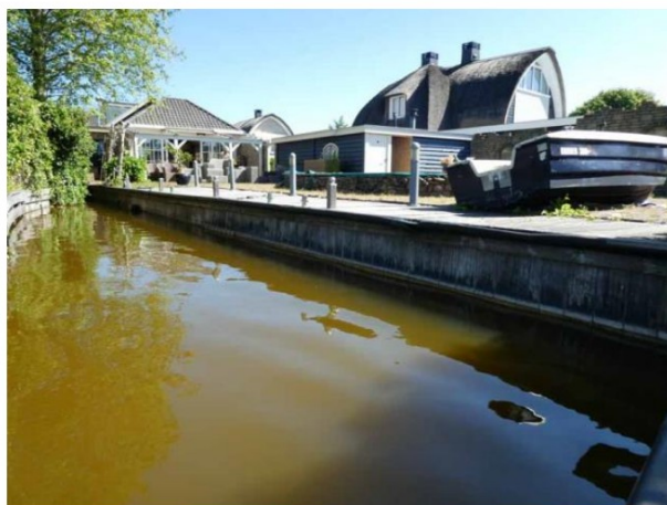
Figuur 9 Hoge hardhouten beschoeiing aan zuidzijde van het plangebied
