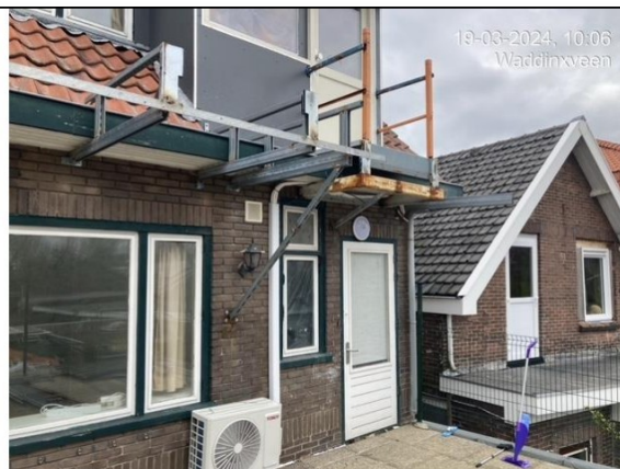
Buitentrap naar 2 e etage is verwijderd
