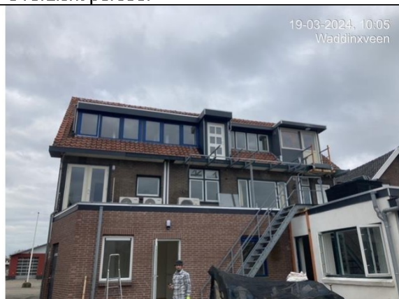
Bovenste dakkapel is verwijderd
