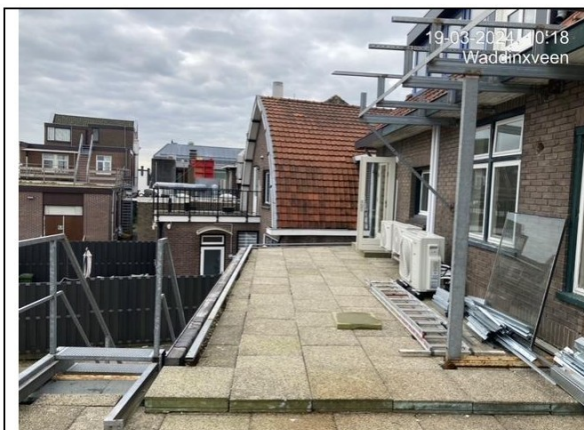
Toegang tot woningen 1 e etage via uitbouw
