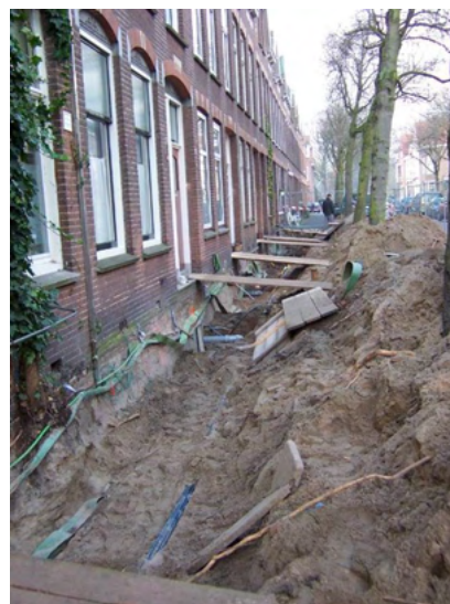
Figuur 6: Werk aan kabels en leidingen.
