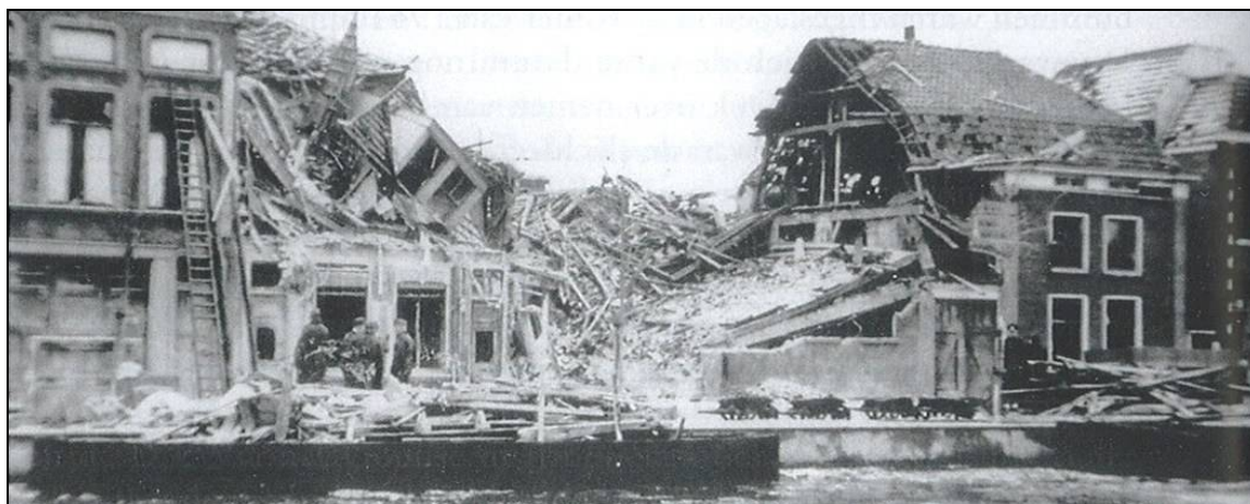
Figuur 7: Schade Fluwelensingel nrs. 42, 43 en 44 na bominslag op 25-2-1941 (Bron: DAM, blz. 98).
