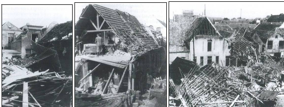
Figuur 21: Schade woningen Nobelstraat na bombardement op 18 september 1944 (bron: DAM, blz. 111-113).
